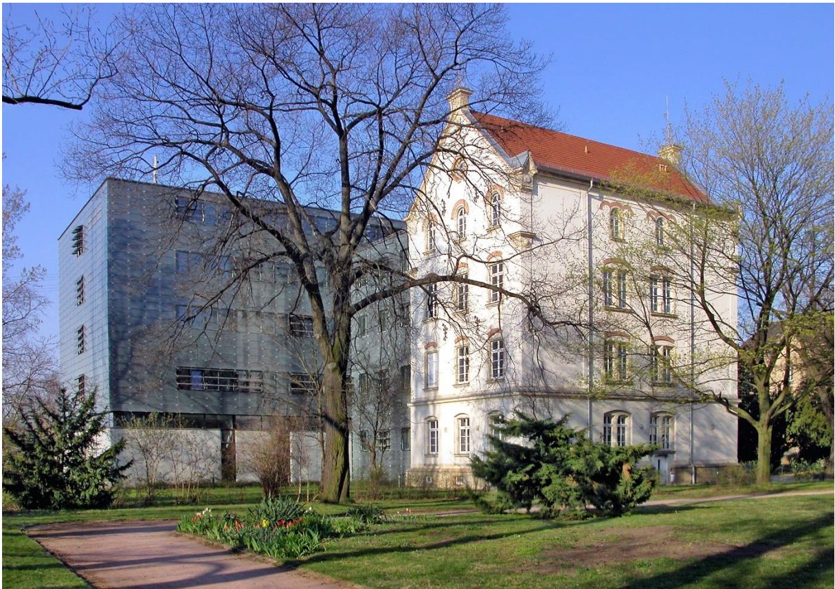
Abb. 3: Untersuchungsobjekt, Ansicht von Nordost
