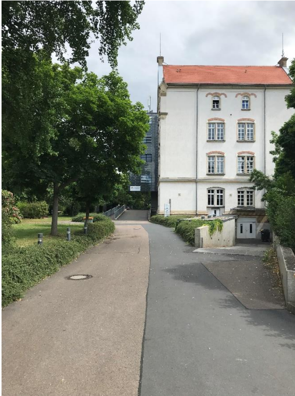
Abb. 5: Untersuchungsobjekt, Ansicht von Südwest mit Anlieferung im Untergeschoss
