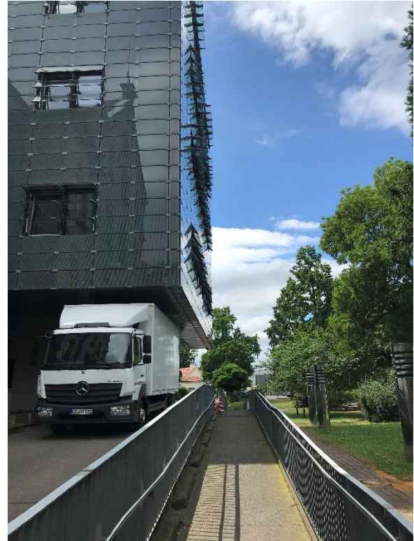
Abb. 4: Befahrbare Rampe am Eingang und Nordwestfassade Neubau
