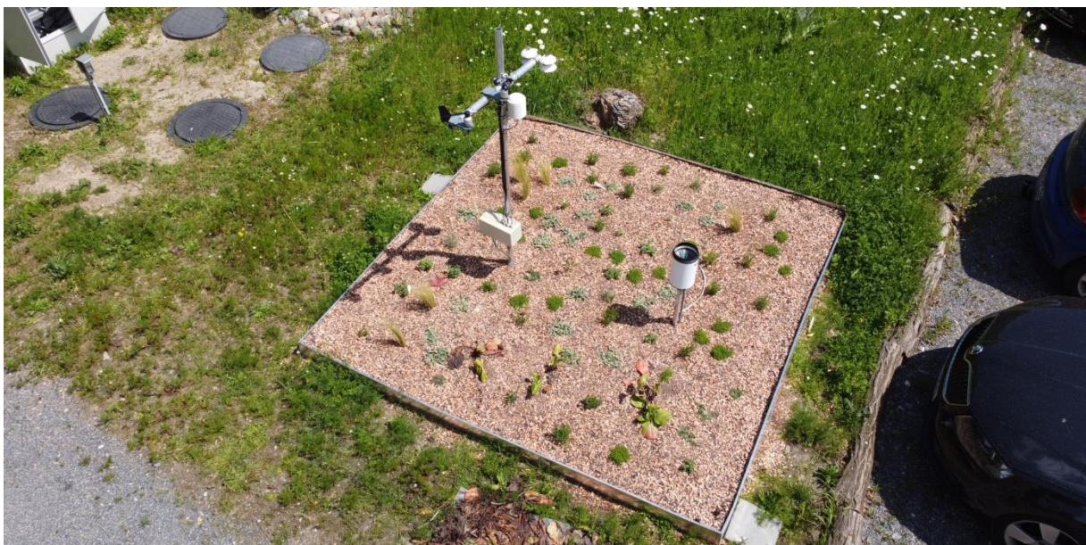
Abbildung 14 Pflanzenkläranlage mit Wetterstation Quelle: Modellprojekt Integrales Wassermanagement
