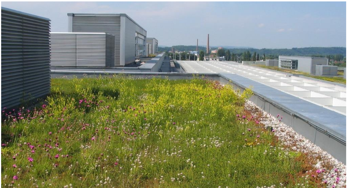
Abbildung 3 Extensiv begrüntes Dach Wasser
