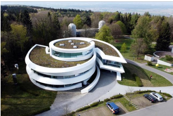
Abb. 5 - Extensiv begrüntes Dach (Haus der Astronomie, Heidelberg)
