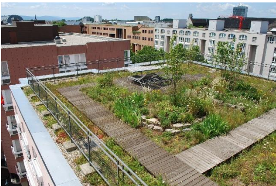
Abb. 6 - Einfach intensiv begrüntes Dach (Amt für Umwelt- & Arbeitsschutz, Karlsruhe)
