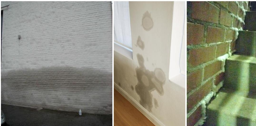
Bild 12 Hygroskopische Feuchte und Salze auf einer Außen-(links) und Innenwand (Mitte); rechts: Salz kristallisiert an der Oberfläche aus
