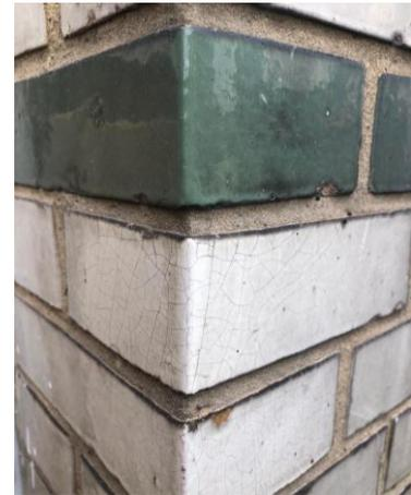
Glasierte Ziegel (frühes 20. Jhd.); das Mauerwerk kann noch durch die Fugen austrocknen
