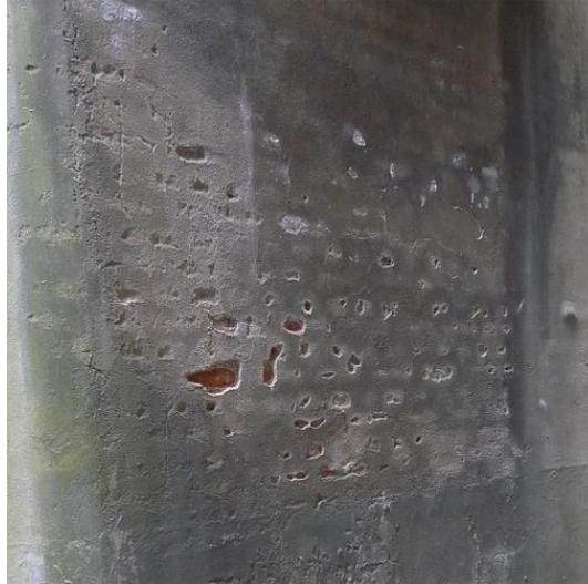
Schäden an einem Außenputz, hauptsächlich wegen Salzkristallisation. Die Unterschiede in der Porosität und Porengrößenverteilung zwischen Putz, Mörtel und Ziegeln führen zu diesem spezifischen Schadensbild
