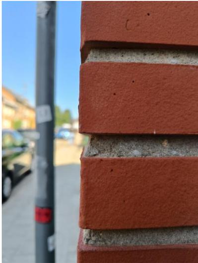
Bei so genannten "Schattenfugen" (oder "Dudok-Fugen") läuft Regenwasser langsamer ab und das Wasser hat mehr Zeit zum Eindringen
