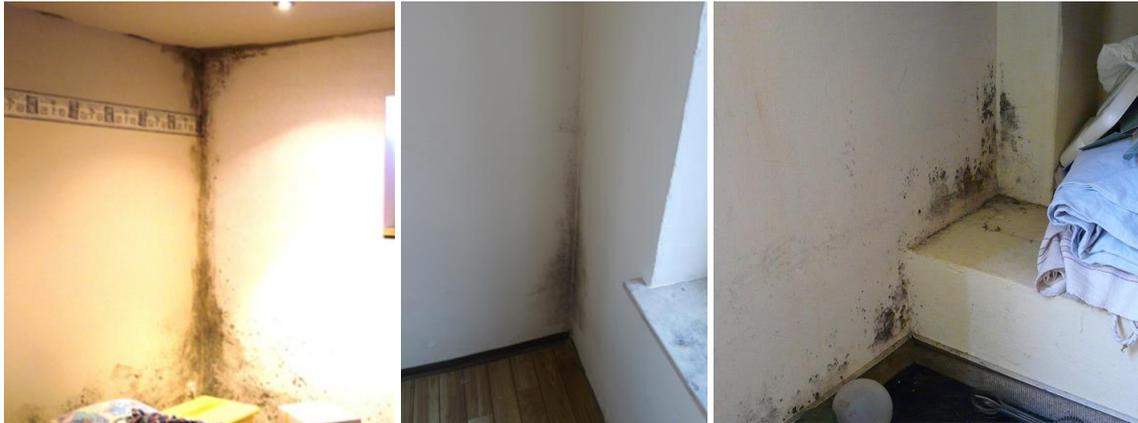
Bild 13 Schimmel/Kondensation im Bereich von Wärmebrücken
