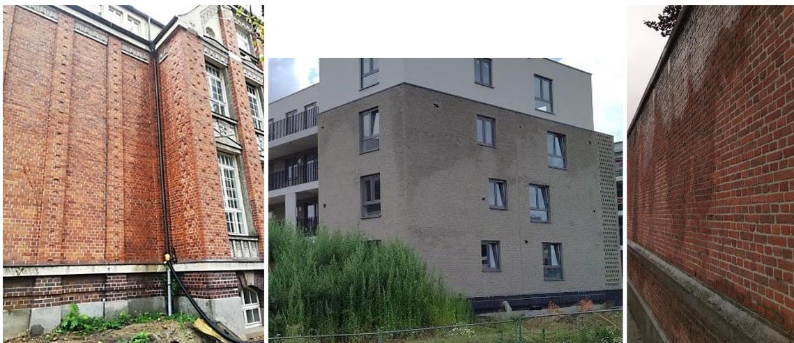
Bild 5 Begehung nach einem Regenereignis zur visuellen Überprüfung der Feuchteverteilung auf Fassadenoberflächen
