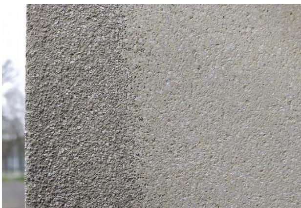
Bild 8 Unterschiedlicher Zustand der Oberfläche, hier das "Ausspülen" des Bindemittels, kann ein Hinweis auf Unterschiede in der Schlagregenbelastung sein
