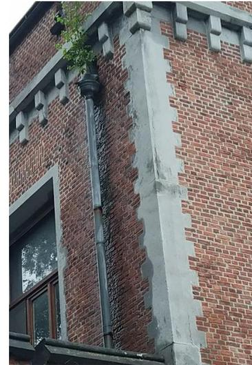
Wasser läuft wegen eines verstopften Rohrs über die Fassade
