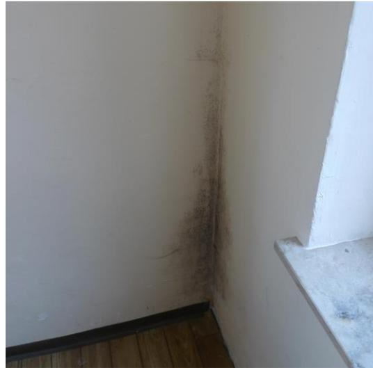
Schimmelbildung aufgrund niedriger Oberflächentemperatur in einer Ecke einer ungedämmten Wand
