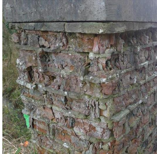
Zersetzung von Ziegeln aufgrund von hoher Nässe und Frost
