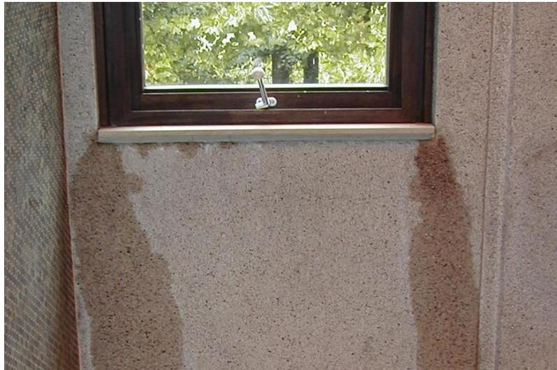
Eindringen von Wasser über undichte Fugen zwischen Fenster und Wand
