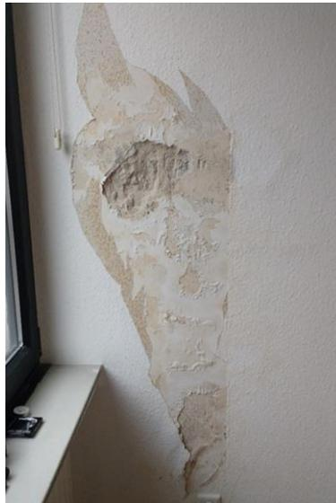
Nach Entfernen der Tapete sichtbare Schimmelflecken
