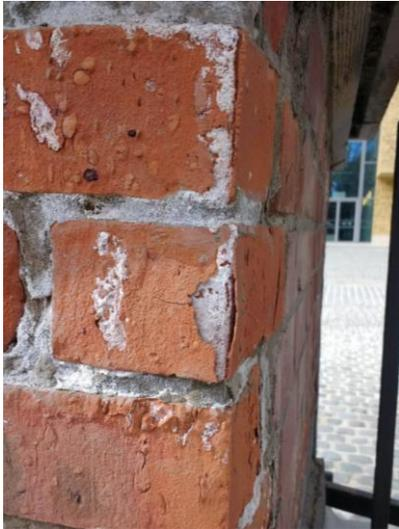
Verlust der Oberfläche durch Auftragen eines wasserabweisenden Mittels auf eine feuchte und salzbelastete Wand
