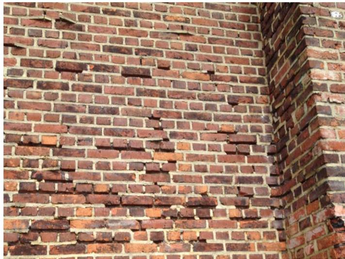
Ein altes Mauerwerk, das mit einem Mörtel mit weißem Portlandzement als Bindemittel neu verfugt wurde. Der neue Fugenmörtel ist durch Frostschäden im älteren Bettungsmörtel herausgedrückt worden.
