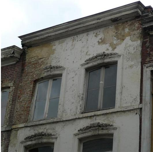
Frostschäden am Außenputz, die durch eine verstopfte Dachrinne entstanden sind, die den Putz aufgefeuchtet hat
