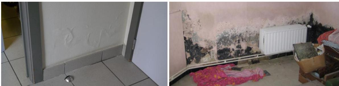
Bild 10 Aufsteigende Feuchte an einer Innenwand (links) und an einer Außenwand (rechts)
