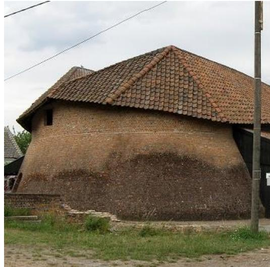
Verfärbung einer geneigten Fassade aufgrund von Bakterienwachstum, verursacht durch Regenwasser, das von einem Dach ohne Dachrinne abläuft. Die Bakterien sind weniger das Problem als vielmehr ein Symptom der hohen Regenwasserbelastung
