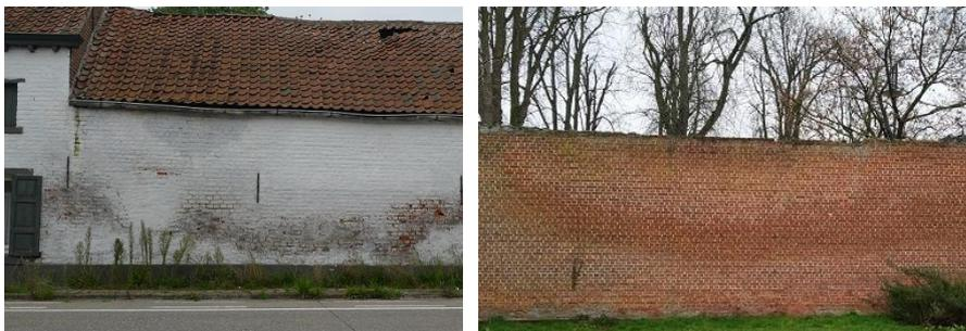
Bild 11 Rein visuell ist es nicht immer einfach, die Feuchtigkeitsquelle zu erkennen. Links aufsteigende Feuchte, rechts hygroskopische Salze
