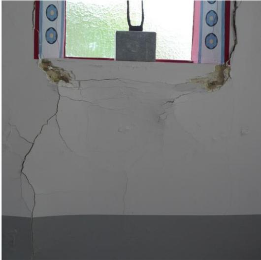
Putzschäden aufgrund von eindringendem Schlagregen
