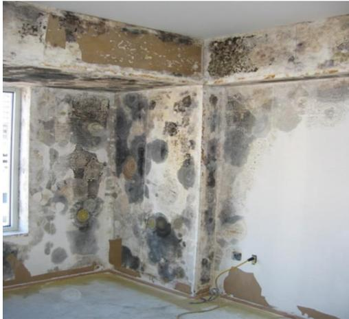
Bild 14 Schimmelwachstum hinter einer entfernten PVC-Tapete (Quelle: Wiss J. Elstner Associates, Inc.)
