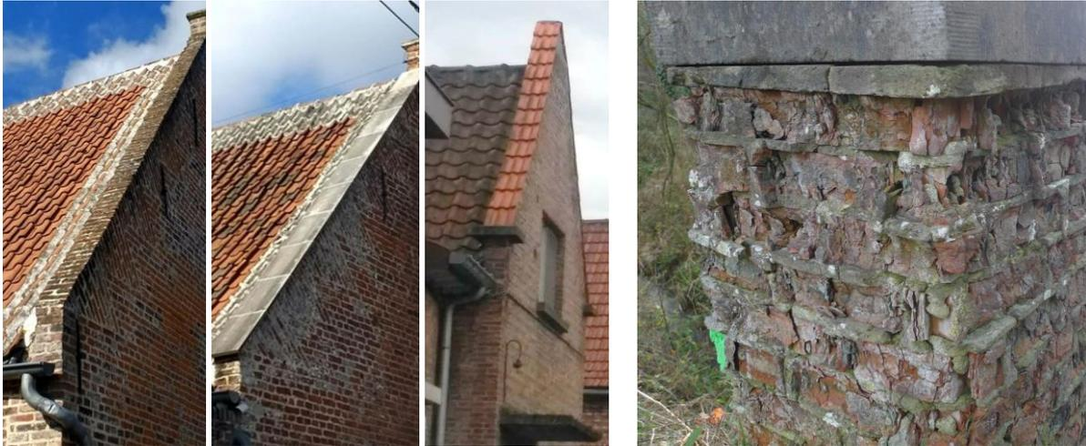
Links: Das Fehlen einer Abdeckung kann zu einem höheren Feuchtegehalt in der Wand führen. Mitte und rechts: praktikable Lösungen für die Wandverkleidung
