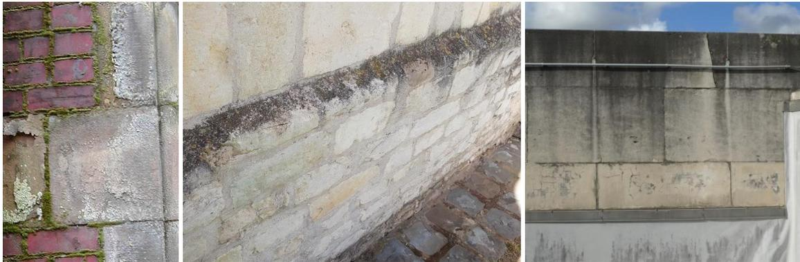
Bild 6 Wachstum von Moosen, Algen und Bakterien an regenwasserbelasteten Fassaden
