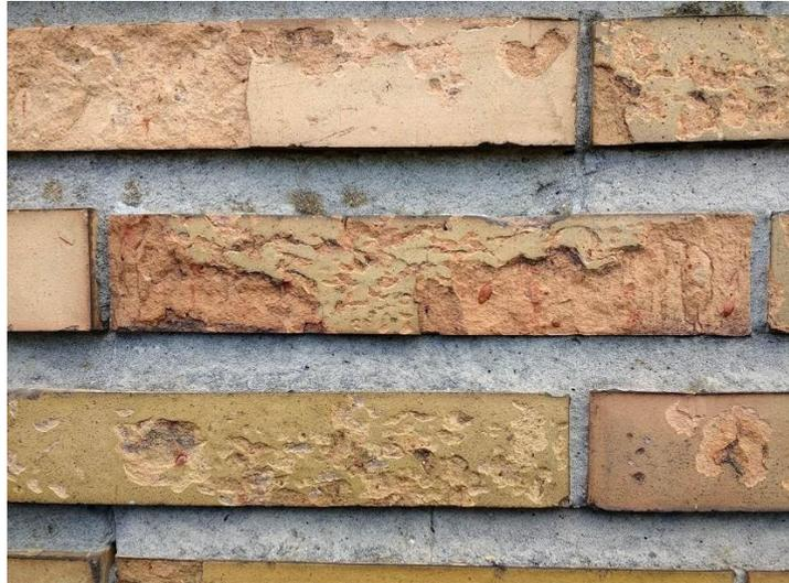
Verlust der Salzglasur durch Frost des feuchten Materials hinter der dichten Deckschicht
