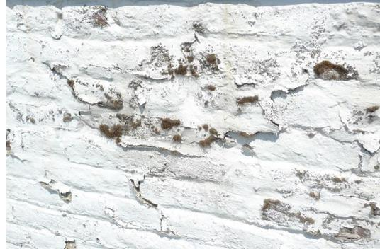
Schadhafte diffusionsdichte, Beschichtung
