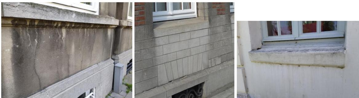
Bild 7 Unterschiede in der Verschmutzung unter einer Fensterbank. Links: abgesehen von einigen Abflüssen ist die Oberfläche unter der Fensterbank vor Wasser gut geschützt, da sie mit Ruß verschmutzt ist; Mitte: die Oberfläche unter der Fensterbank ist sauberer, was darauf hindeutet, dass sie dem Regen ausgesetzt ist; rechts: der Abfluss von Wasser unter der Fensterbank zeichnet sich gut ab
