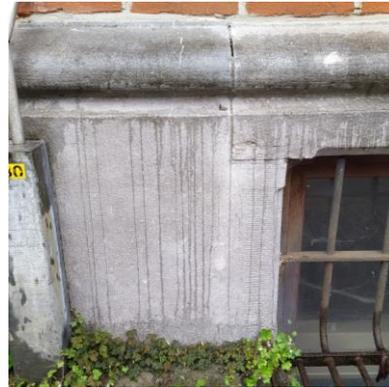
visueller Hinweis auf das Vorhandensein eines wasserabweisenden Produkts: die Oberfläche kann nicht benetzt werden, Wasser, das von der Fassade abläuft, bildet feine Rinnsale oder Tröpfchen
