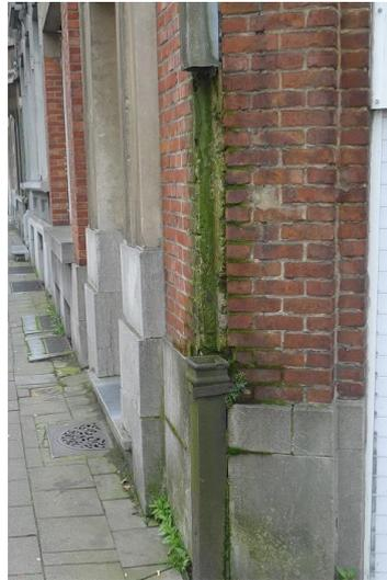
Algen und beschädigter Mörtel aufgrund eines fehlenden Fallrohrs
