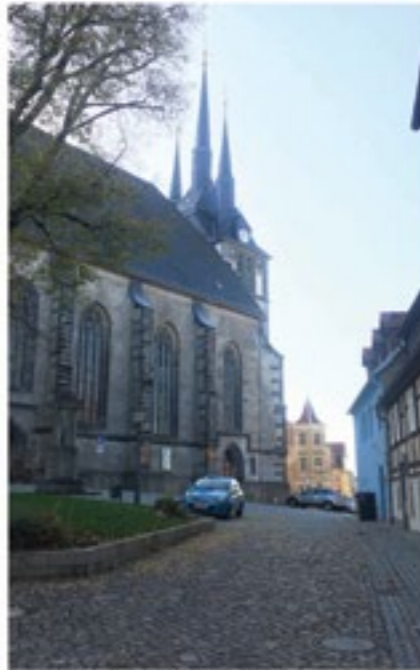
Abb. 6: Altstadt - St. Wendzelkirche, Vorplatz
