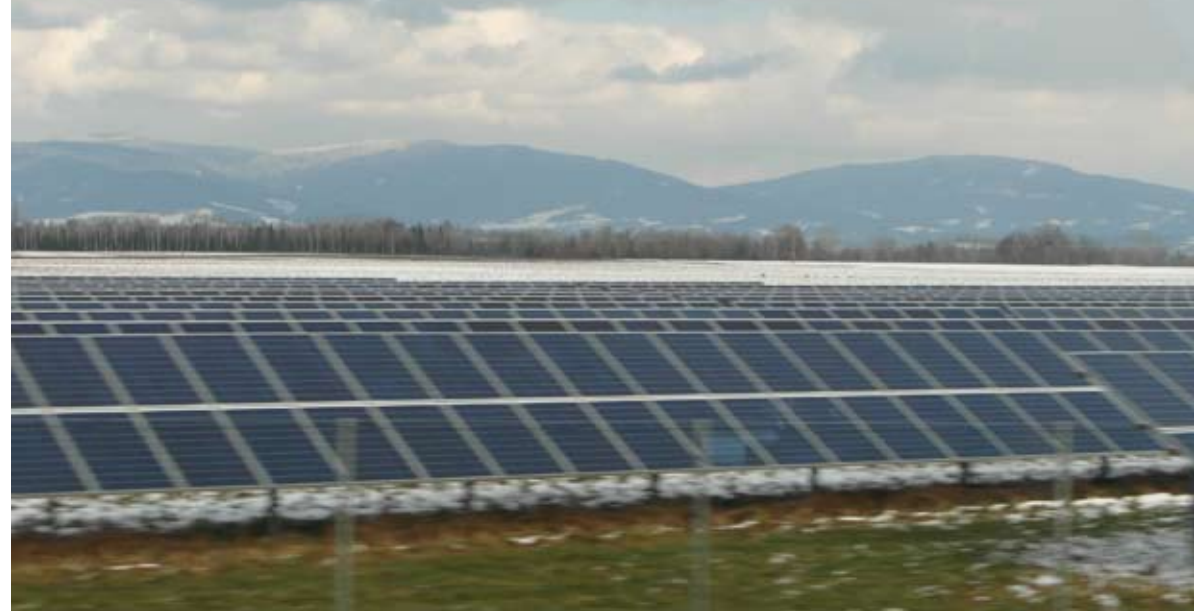
Abbildung 2: Photovoltaik-Freiflächenanlage bei Regensburg-Plattling mit Blick aus dem Zug zum Bayerischen Wald. Foto: Markus Schwarzer.
