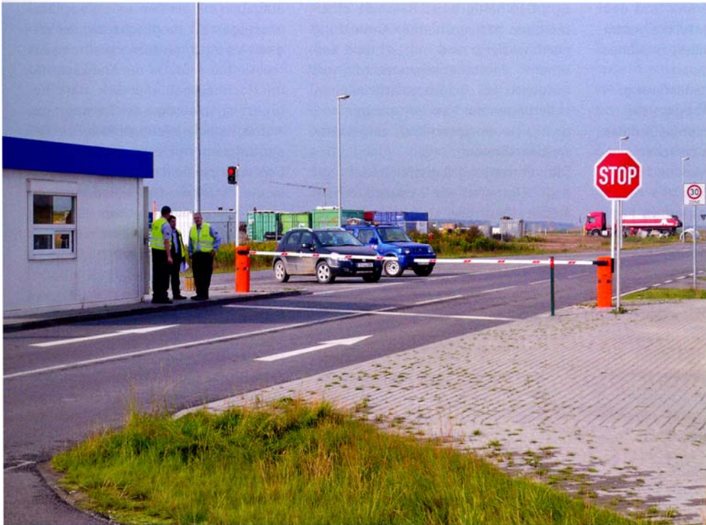
Gut gesicherte Zugangseinrichtung für Fahrzeuge und Personen; Airport Berlin Brandenburg International BBI.
