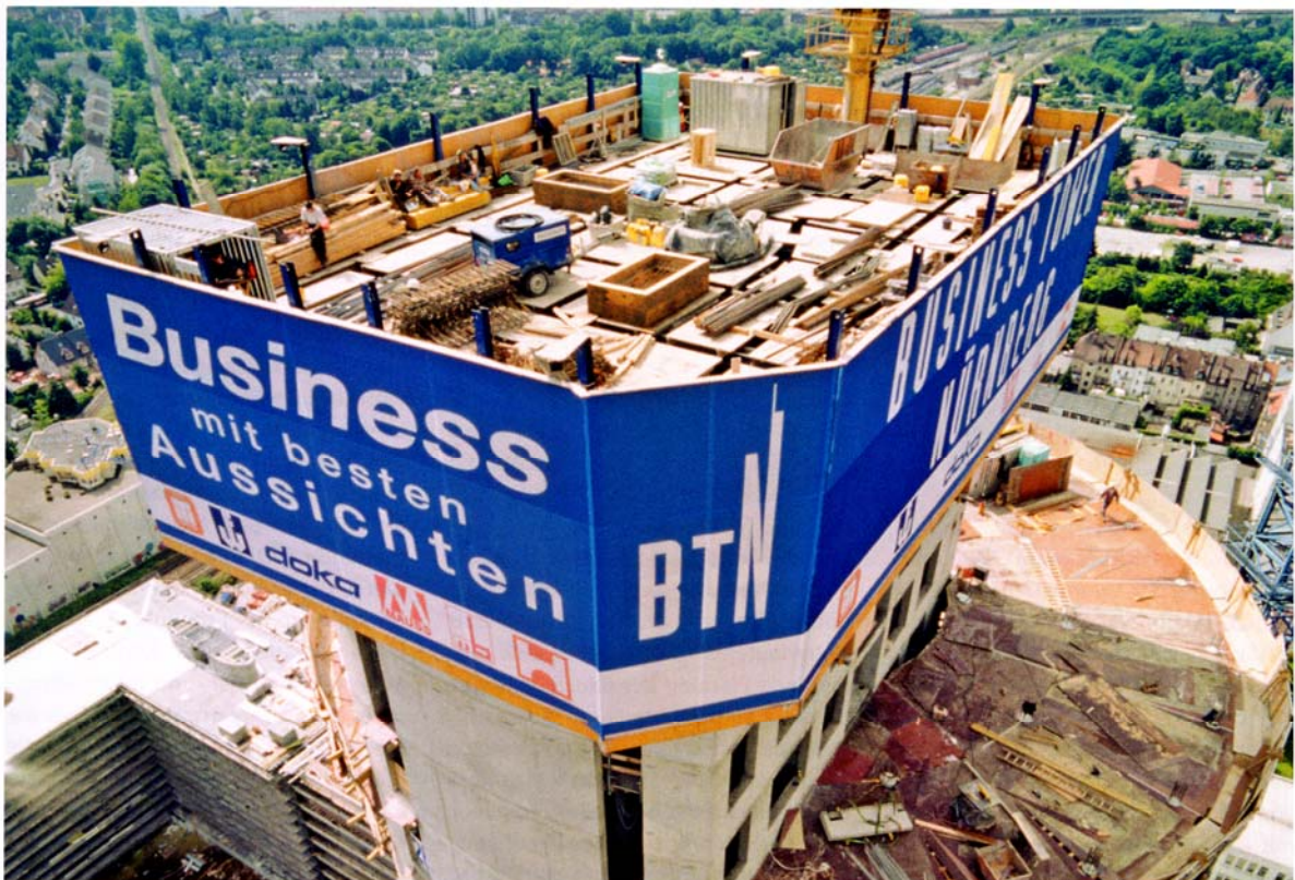
Lagerflächen auf einer selbstkletternden Schalungs- und Arbeitsplattform; Versicherungsgebäude Nürnberg. Quelle: www.doka.de
