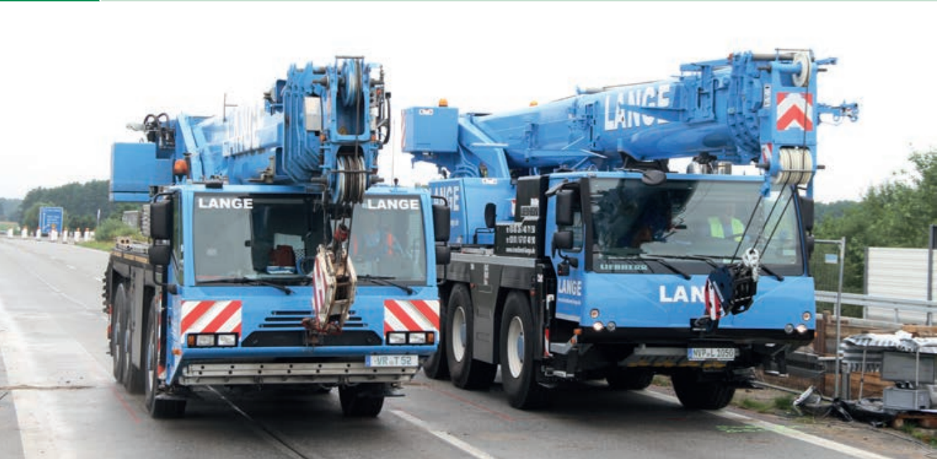
Belastungsfahrzeuge auf der Brücke bei Probelastung | Loading vehicles on the bridge during the load test | Photo: Sabine Wellner
