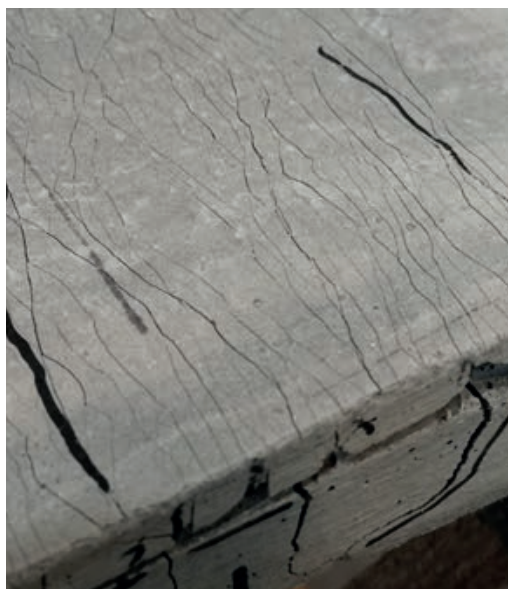
Probekörper nach dem Versagen | Test specimen after failure | Photo: Stefan Gröschel
