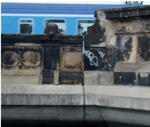
Geländer auf der Marienbrücke | Railing on the Marienbrücke | Photo: Tobias Gestrich
