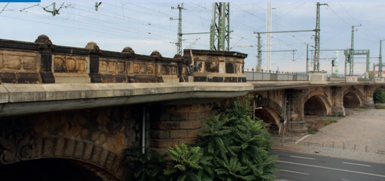
Die Marienbrücke in Dresden, Beispiel einer Eisenbahngewölbebrücke | The Marienbrücke in Dresden, example of an arched railway bridge | Photo: Tobias Gestrich
