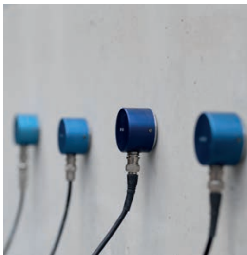
Ultraschalluntersuchung bei einem großformatigen Balken | Ultrasonic investigation of a large concrete beam | Photo: Sebastian Schneider
