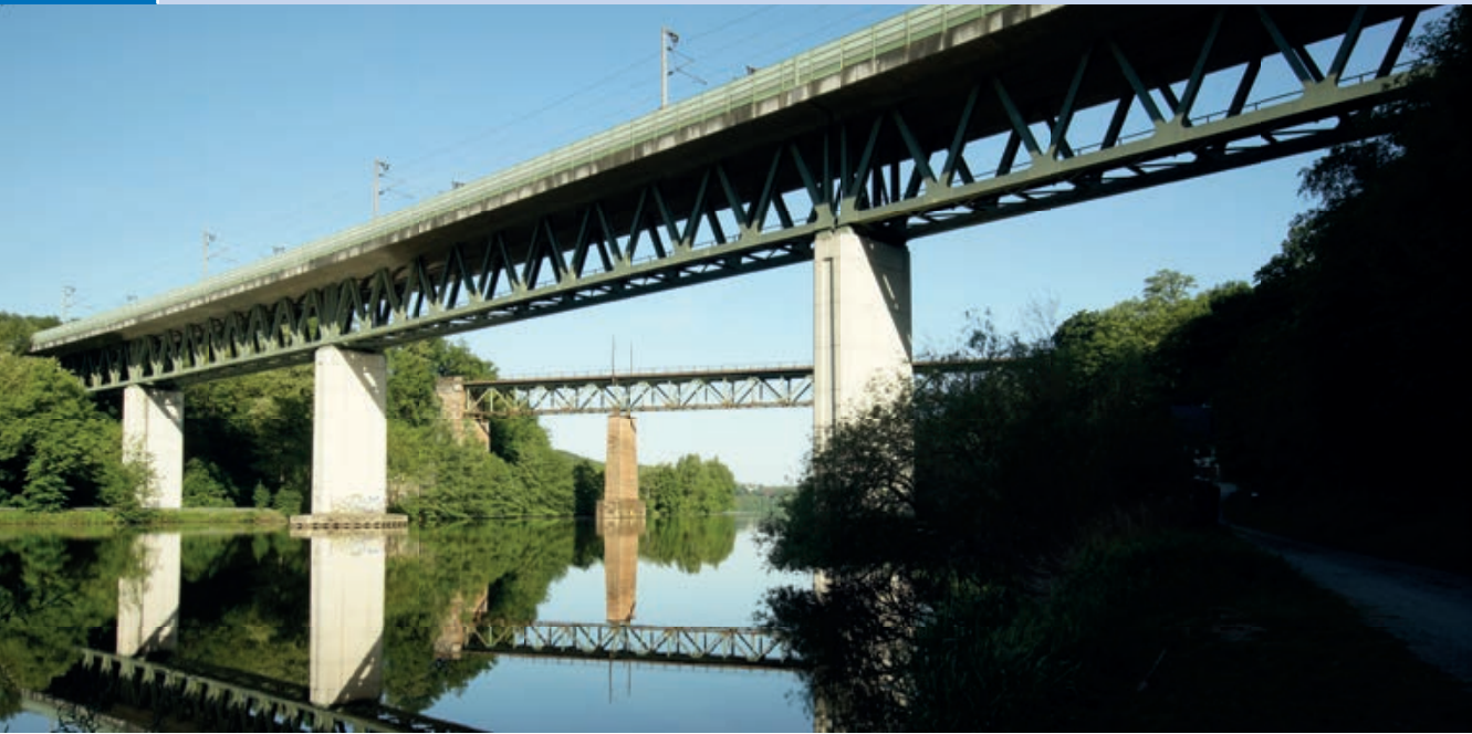
Fuldatalbrücke Kragenhof | Fuldatal bridge Kragenhof | Photo: MKP GmbH
