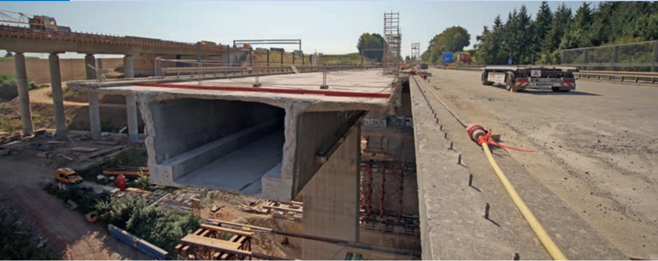
Rückbau der Lahntalbrücke | Deconstruction of the Lahntal Viaduct | Photo: Ludolf Krontal
