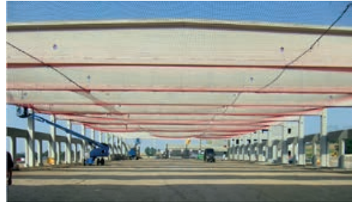
Hallenkonstruktion mit Stahlbetonbindern | Foto: Ingenieurgesellschaft Beton-Fertigteil-Bau IGBFB mbH
