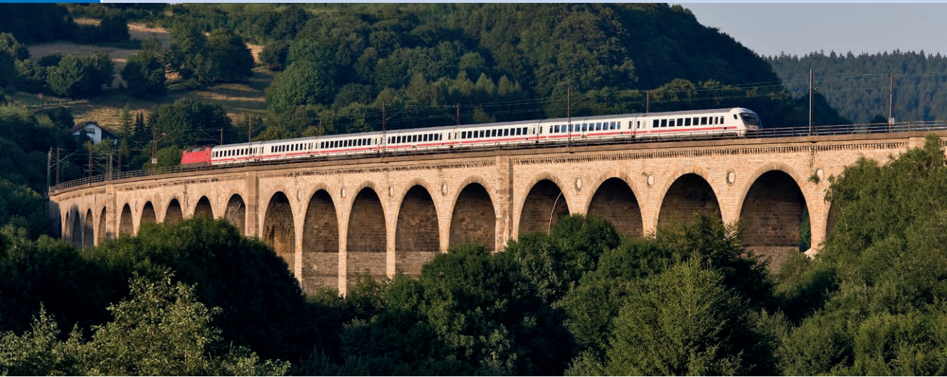
Altenbekener Vaidukt (NRW) mit einer Länge von 482 m und 24 Gewölb Bögen | Altenbekener vaidukt (NRW) with a length of 482 m and 24 vaulted arches | Photo: Georg Wagner
