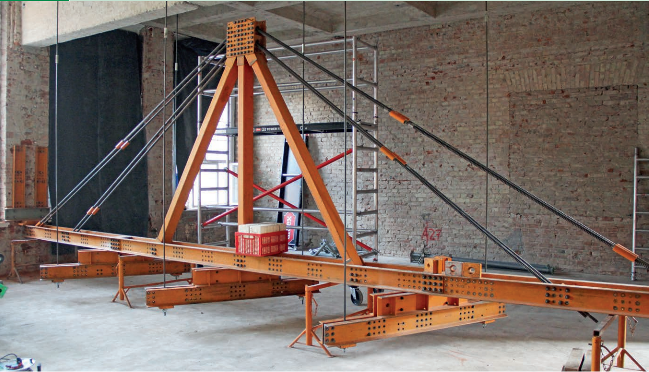
Rahmenkonstruktion unterhalb der Kassettendecke | Frame construction underneath the cassette slab | Photo: Sabine Wellner
