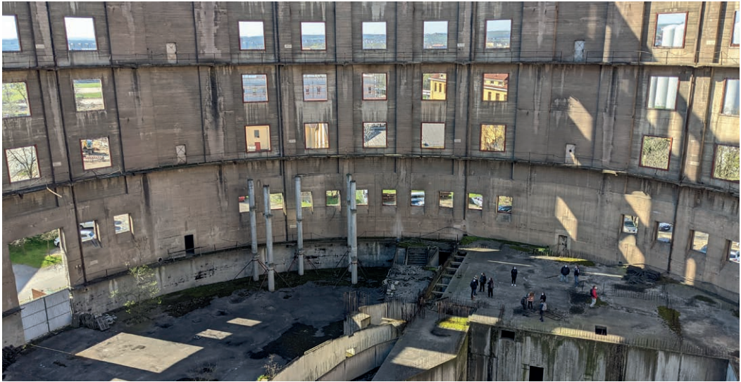
Im Innern des Gasspeichers Dresden-Reick | Inside the Dresden-Reick gas storage facility | Photo: Kerstin Speck
