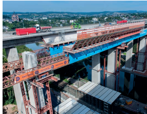
Einsatz der Vorschubrüstung von RöRo | Foto: thyssenkrupp Infrastructure GmbH
