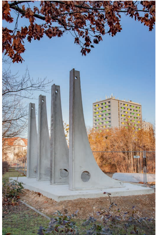
Sogar das Bauschild wird mit Carbonbeton realisiert | Foto: Stefan Gröschel
