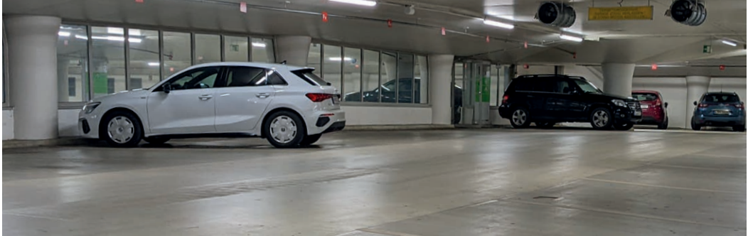
Tiefgarage mit Oberflächenschutzsystem | Foto: Kerstin Speck
