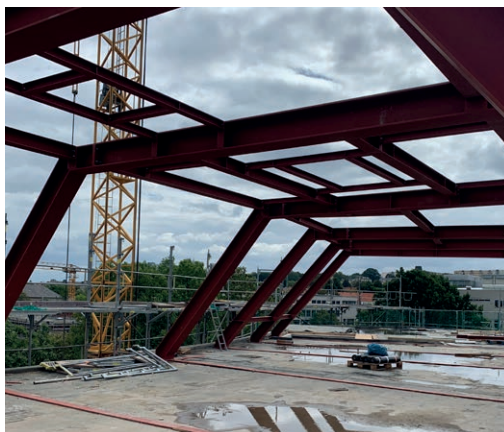
Stahlkonstruktion des neuen Dachstuhls | Steel construction for the new roof | Photo: Ulrike Penzl, H.F.Z. Architekten
