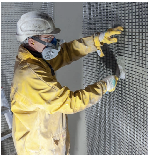
Fertigung eines Carbonbetonbauteils | Manufacturing of a carbon reinforced concrete component | Photo: Stefan Gröschel
