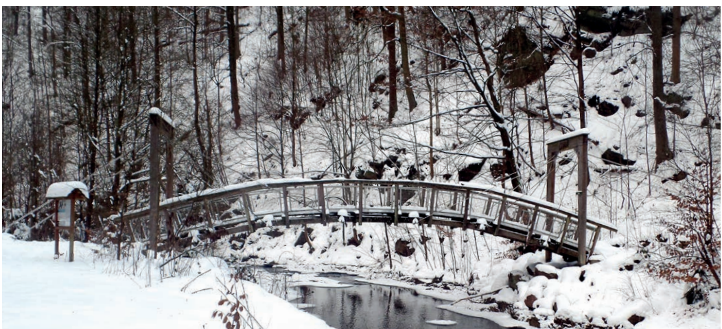
Arthur-Lohse Brücke im Forstbezirk Bärenfels | Foto: Jakob Sitter
