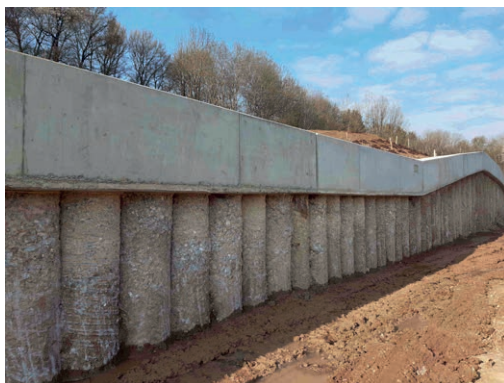
Bohrpfahlwand zur Hangsicherung | Foto: IGS Ingenieure GmbH & Co. KG
