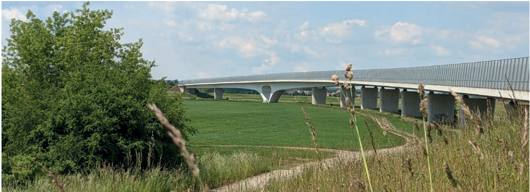
Das Auge von Mühlberg – Beispiel für einen gelungenen Brückenentwurf | The Eye of Mühlberg – Example of a successful bridge design | Photo: Kerstin Speck
