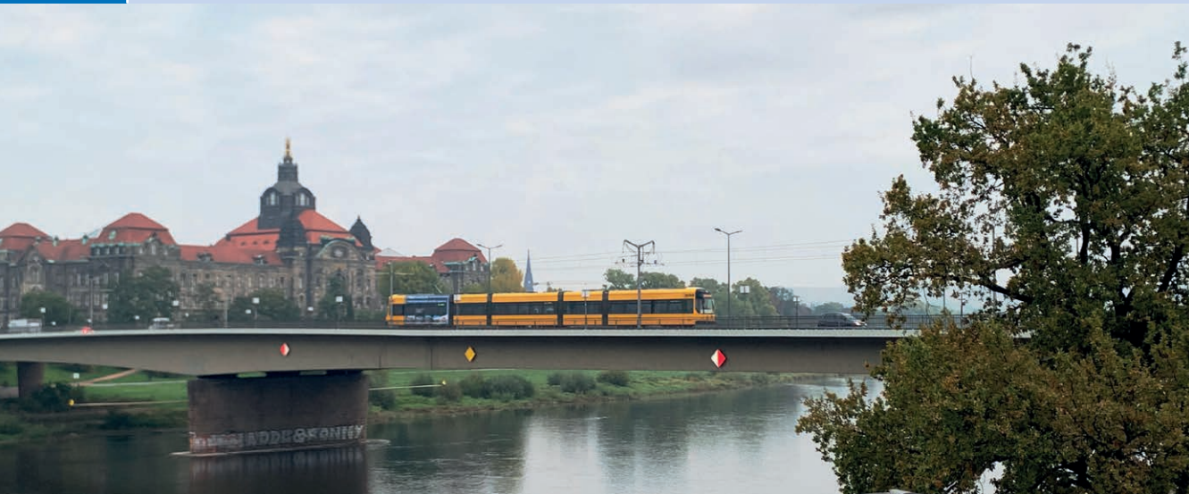
Carolabrücke in Dresden unter zyklischer Belastung | Carola Bridge in Dresden under cyclic loading | Photo: Raúl Enrique Beltrán Gutiérrez
