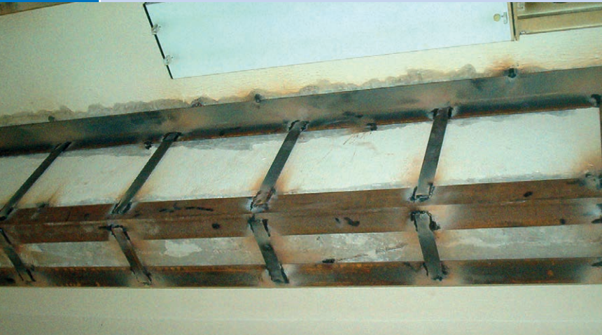
Übliche Verstärkungsmethoden in Syrien | Traditional strengthening methods in Syria | Photos: Zuhair Amer
