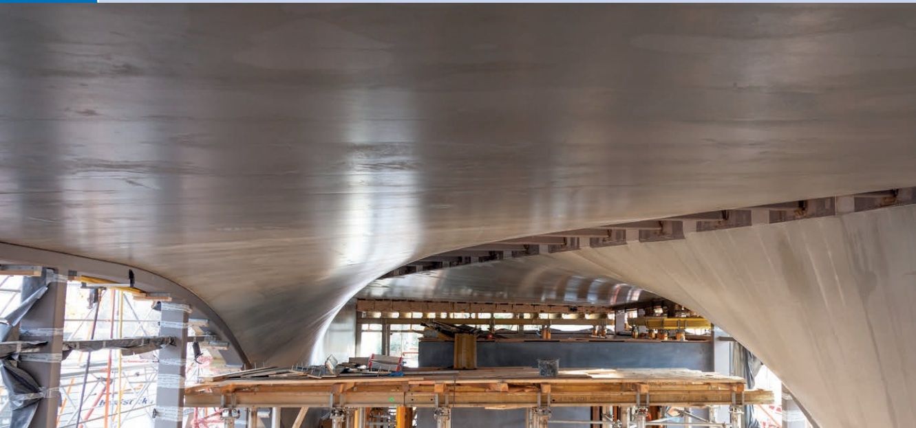
TWIST-Schale im Bauzustand | TWIST shell during erection | Photo: Stefan Gröschel
