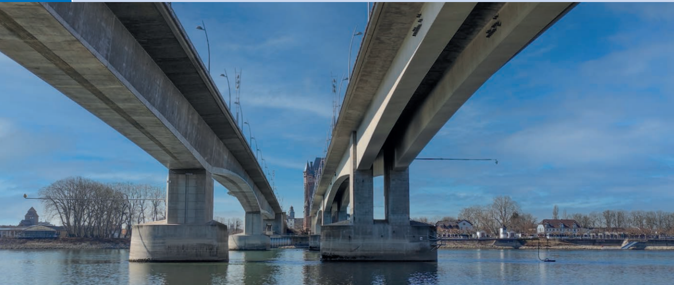
Validierungsbauwerk Nibelungenbrücke Worms | Validation construction Nibelungen Bridge Worms | Photo: Chongjie Kang
