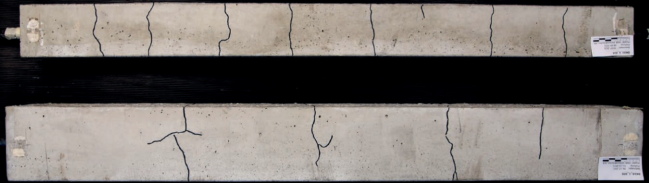
Dehnkörper mit Rissbildung | Tension tie specimens with cracks | Photo: Marc Koschemann
