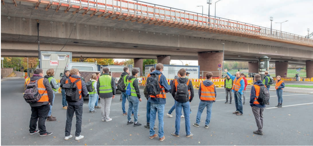
An der Carolabrücke wird eine Kappe erweitert, auch mit Hilfe von Carbon- und Basaltfasern | A canopy is being extended at the Carola Bridge, also with the help of carbon and basalt fibres | Photo: Stefan Gröschel
