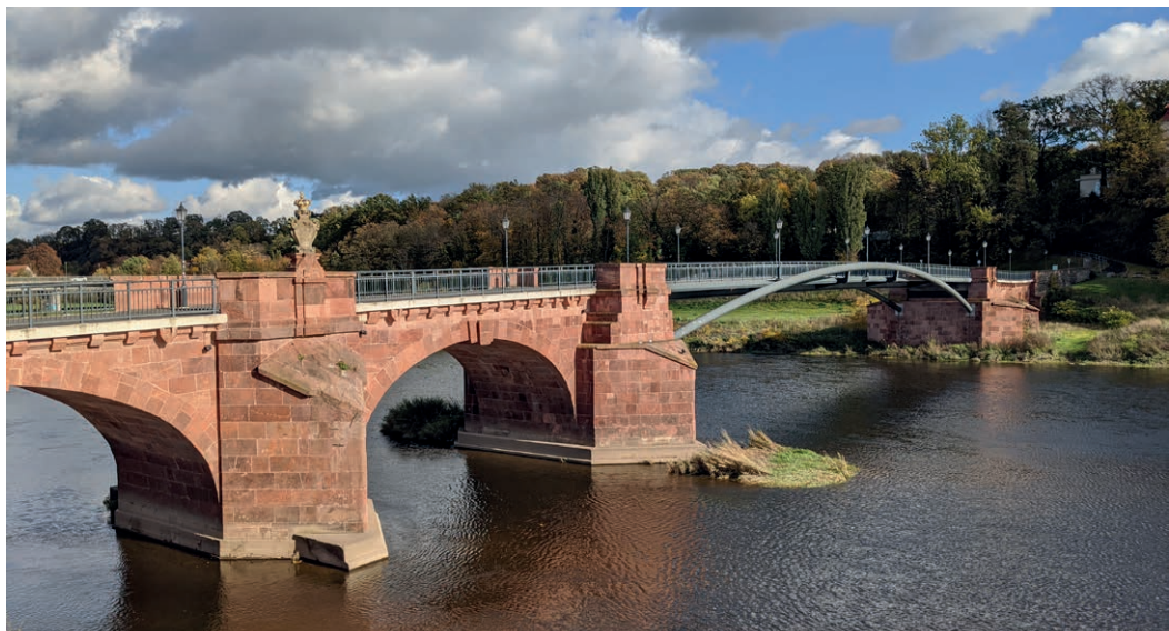
Pöppelmannbrücke über die Mulde in Grimma mit einer Verstärkung der Natursteinbögen aus Leichtbeton | Foto: Kerstin Speck
