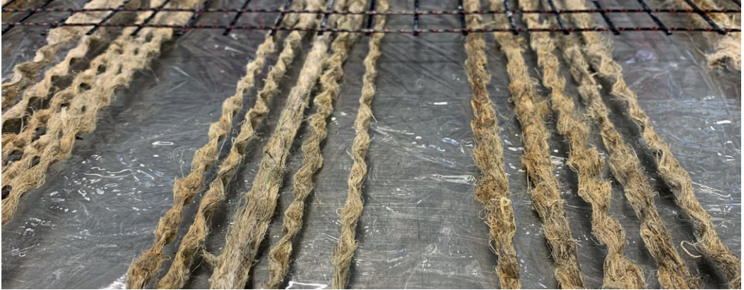
Anordnung der Bewehrungsstäbe aus Naturfasern in der Schalung | Foto: Berthe Roedel
