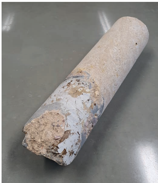
Ilmviadukt – entnommener Bohrkern mit Zementinjektion | Ilmviadukt – extracted drill core with cement injection | Photo: Silke Scheerer
