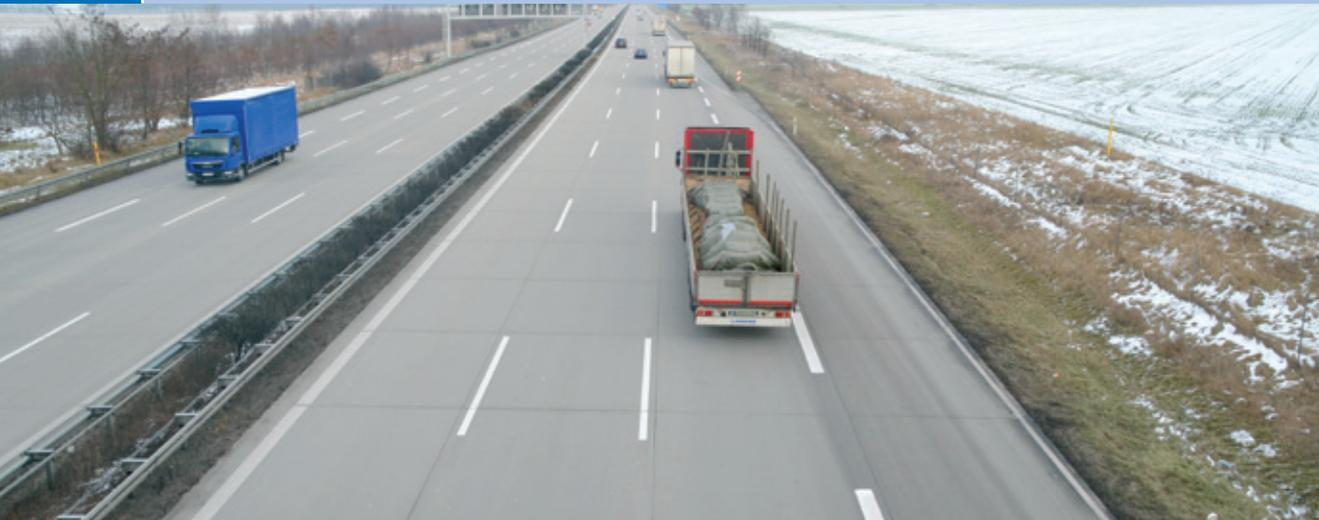
Klassische Fahrbahndecke in Betonbauweise | Typical concrete pavement in road constructions
