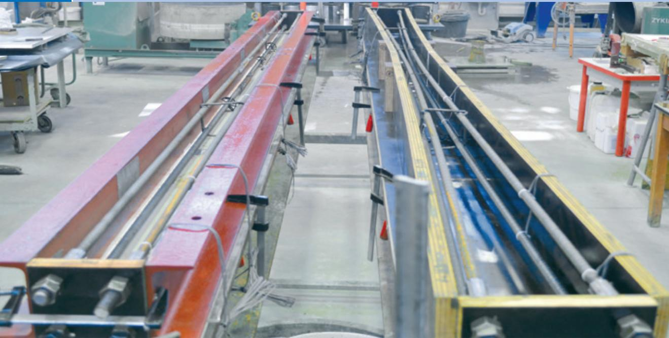
Schalung der Referenzstütze (links) im Vergleich zur optimierten Stützenform (rechts) | Formwork of the reference column (left) in comparison to the optimized shape (right) | Photo: Angela Schmidt
