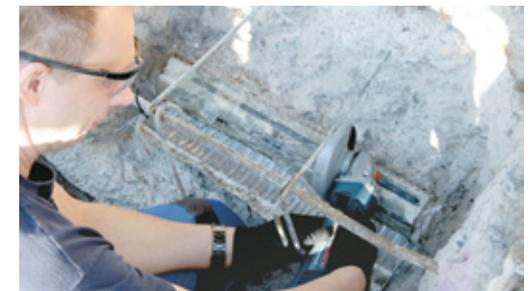
Durchtrennen der Spannstähle | Cutting the prestressing steels
