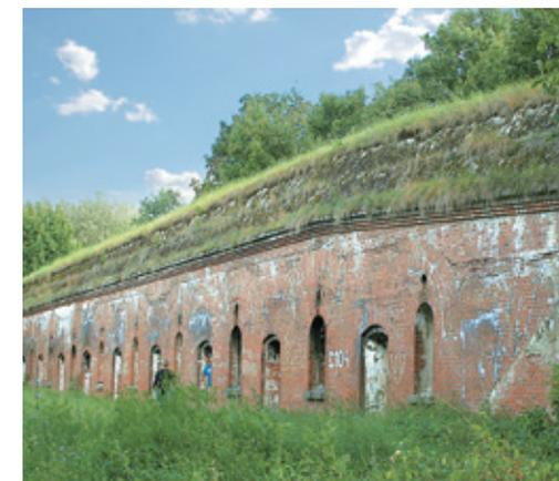
Dämpfung durch viel Material bei einer Schutzkonstruktion
