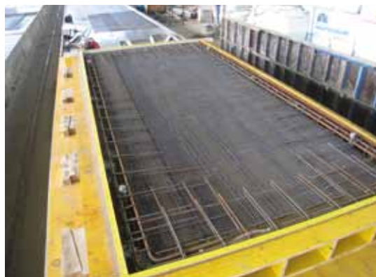
Bewehrung der Balkonplatte
