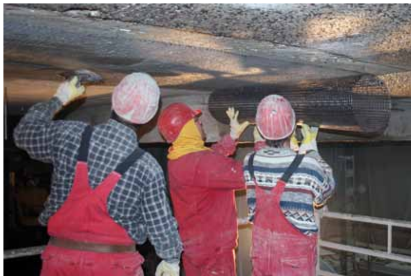
Biegeverstärkung einer Decke mit Textilbeton [Bild: TUDALIT / Silvio Weiland]
