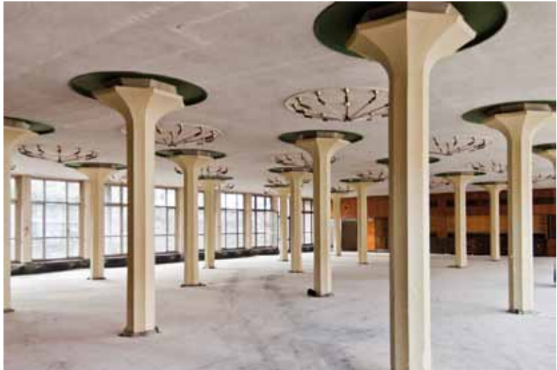
Pilzstützen in der Alten Mensa der TU Dresden während der Rekonstruktion Dendriform columns in Alte Mensa at the TU Dresden during reconstruction
