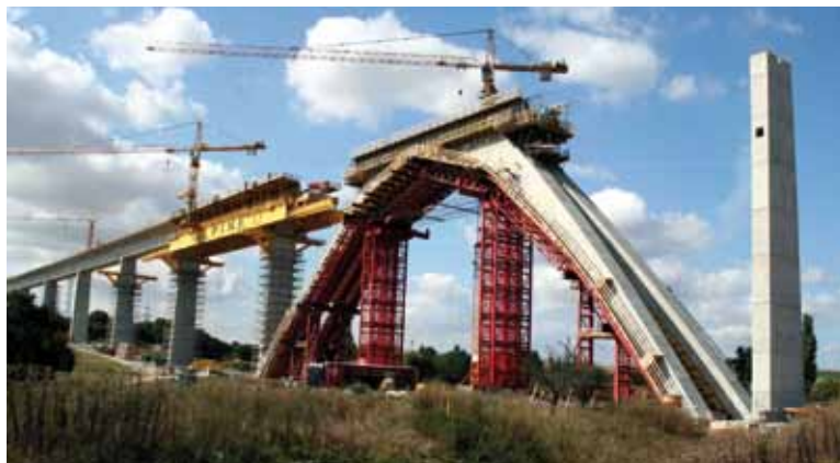
Bau der Unstruttalbrücke in integraler Bauweise 2009 [Foto: Wikipedia/Störfix]
