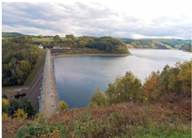
Talsperre bei Bad Gottleuba [Bild: Ulrich van Stipriaan]
