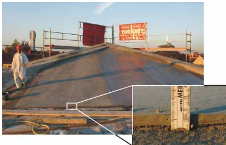
Filigrane Verstärkungsschicht aus Textilbeton Filigrée strengthening layer made of TRC
