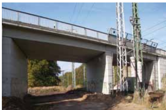
Typisches Balkenreihentragwerk im Brückenbestand Mecklenburg-Vorpommerns [Bild: Torsten Hampel]
