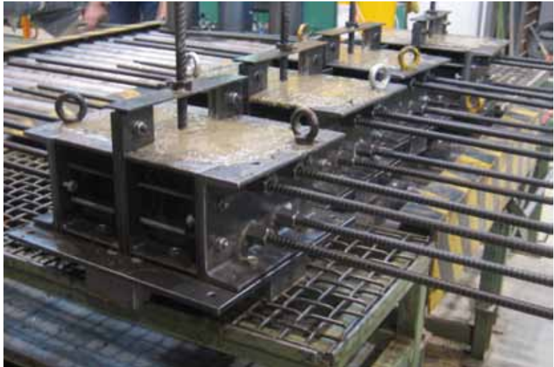
Betonage der Probekörper Casting of the specimens
