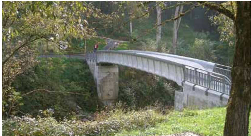
Segmentbrücke aus textilbewehrtem Beton in Kempten
