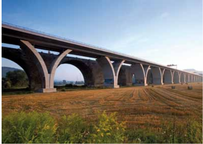
Saaletalbrücke Jena Göschwitz [Bild: Deutscher Brückenbaupreis]
