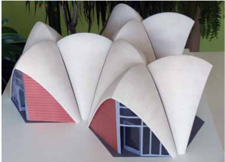
Modell eines Gebäudes aus schalenförmigen Textilbetonfertigteilen
