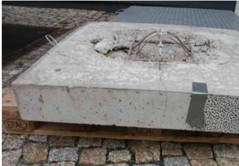
Normalbetonplatte nach dem Impaktversuch (umgedehte Ansicht) Standard concrete slab after the impact test (upside down)
