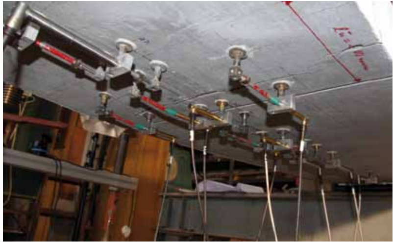
Messtechnik an der Plattenunterseite Measurement on the bottom side of the slab
