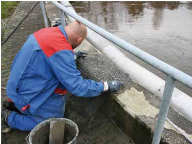
Erprobung einer Sanierungsmöglichkeit mit Textilbeton an einem Klärbecken
