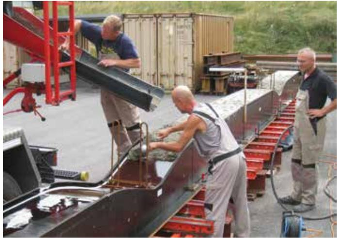
Betonage der unteren Deckenschicht eines geschichteten Großträgers
