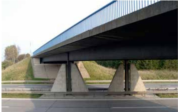
Brücke mit Stahl-Beton-Verbundüberbau zur Nachrechnung auf messwertgestützter Basis (Stufe 3)
