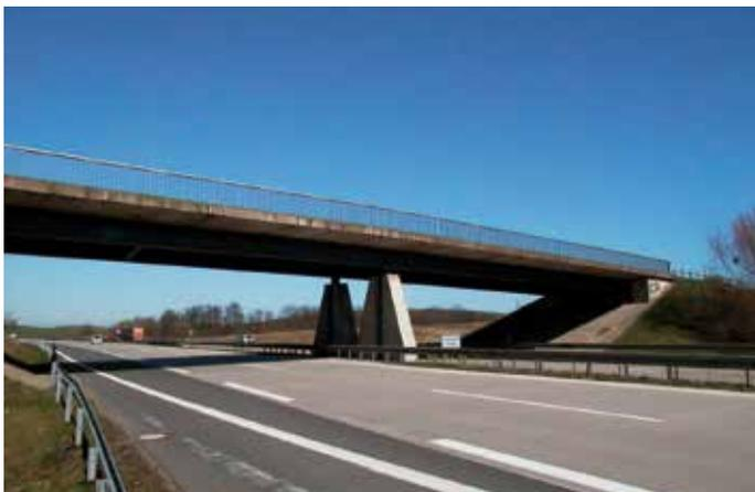
Stahlverbundbrücke mit Betonfertigteilen
