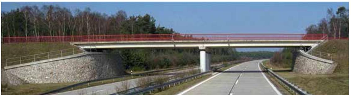
Brücke mit Balkenreihenüberbau BT 700 zur Nachrechnung in Stufe 4
