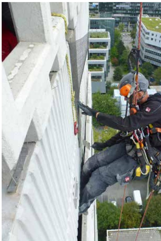
Anbringen der textilen Bewehrung an einem geschädigten Fassadenelement
