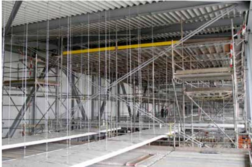
Die neuen Stahl-Fachwerkverbände der Halle 285 im Einbauzustand
