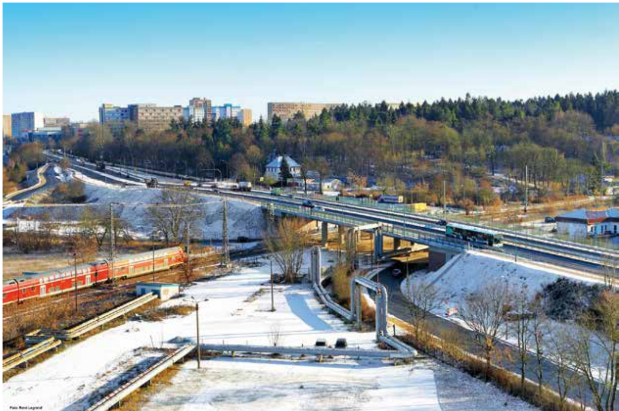
Brücke im Bauzustand
