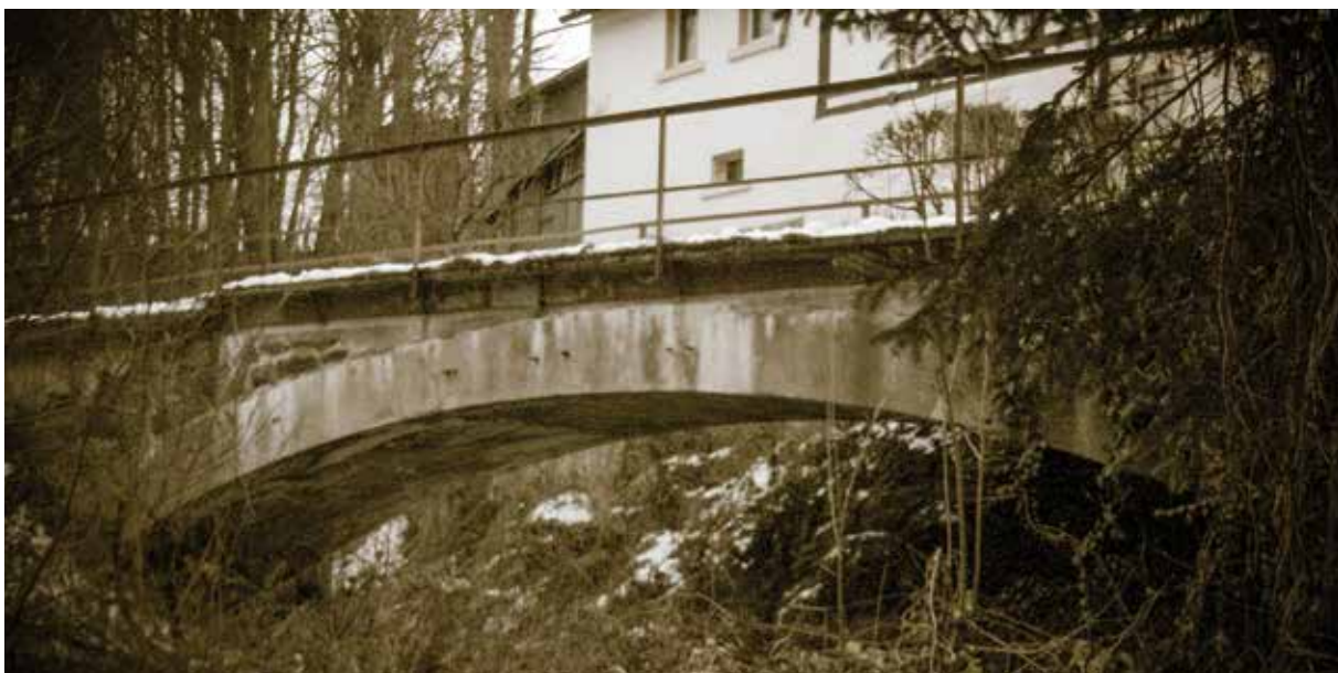
Bild 1: Stampfbetonbogenbrücke in Seifersdorf/Sachsen
