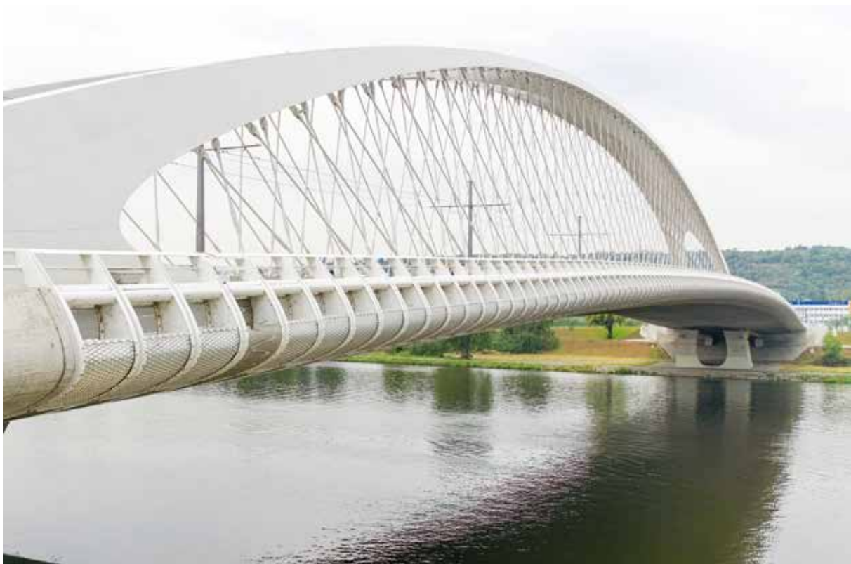
Bild 1: Troja-Brücke – Netzbogenbrücke in Prag/Tschechien
