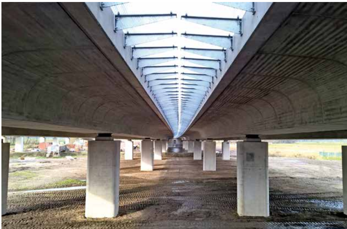
Untersicht der Brücke
