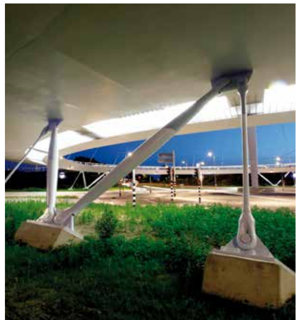
Bild 22: M-förmige Befestigungen – Realisierung
