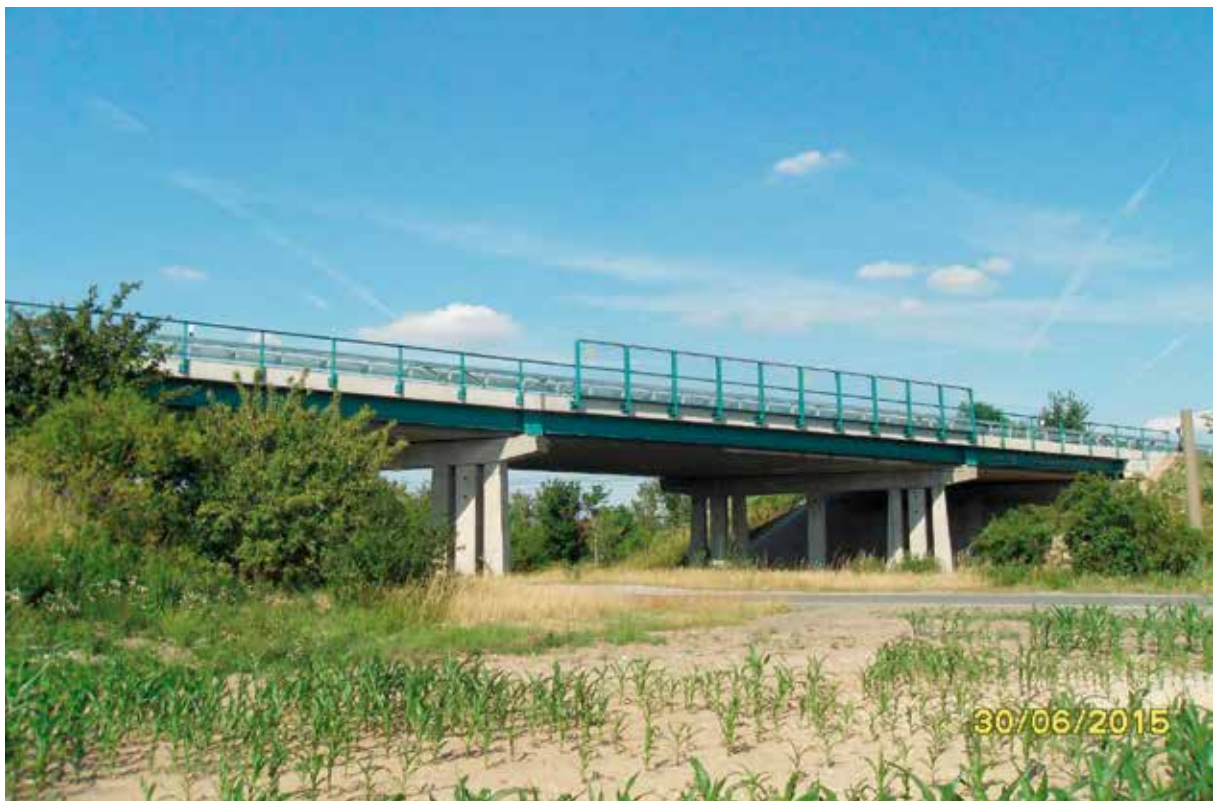
Seitenansicht (Foto: Landesamt für Straßenbau und Verkehr des Freistaates Sachsen, Niederlassung Leipzig)
