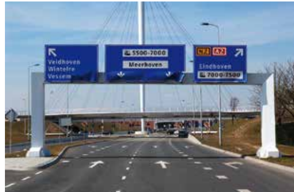
Bild 18: Beschädigtes Zufahrtsportal © ipv Delft
