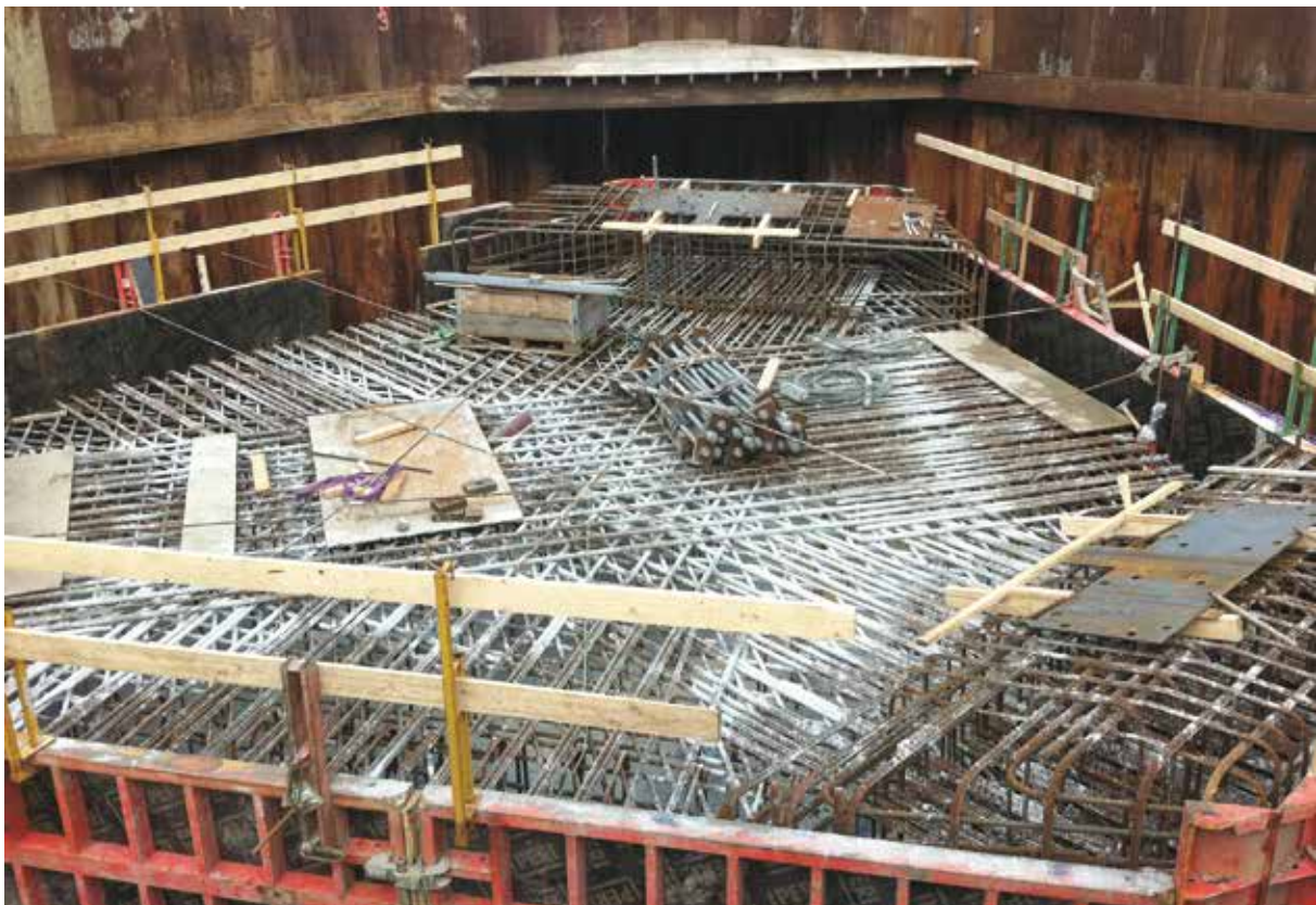
Bild 10: Herstellung der Pfahlkopfplatte der Mittelplattform
