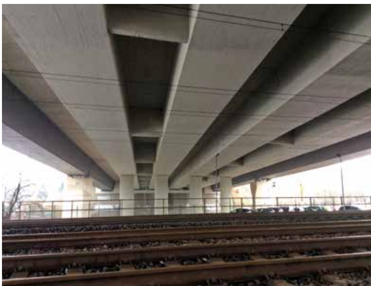
Bild 6: Unterseite der Schwelme-Brücke vor den Ertüchtigungsmaßnahmen 2015 (Foto: Annette Jarosch, BBV)
