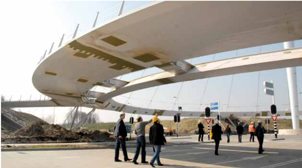
Bild 31: Brückendeck während der Realisierung
