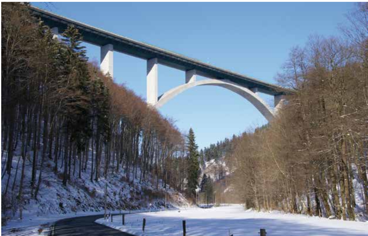
Bild 1: Talbrücke Wilde Gera, entworfen von Roland von Wölfel
