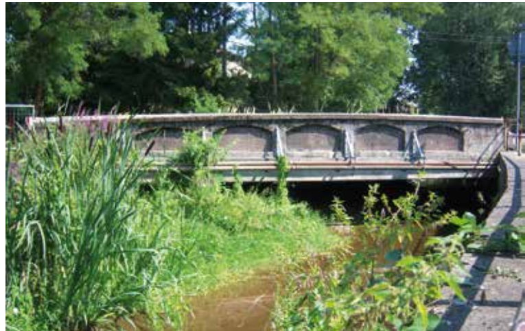
Bild 13: Vermutlich älteste erhaltene Stahlbetonbrücke Mitteldeutschlands im Sommer 2015 (Foto: Oliver Steinbock)
