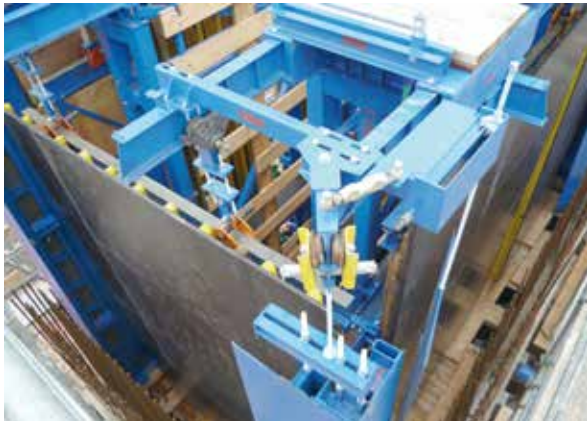
Bild 19: Innenschalung und Eckelement (© Hünnebeck Deutschland GmbH, Ratingen)
