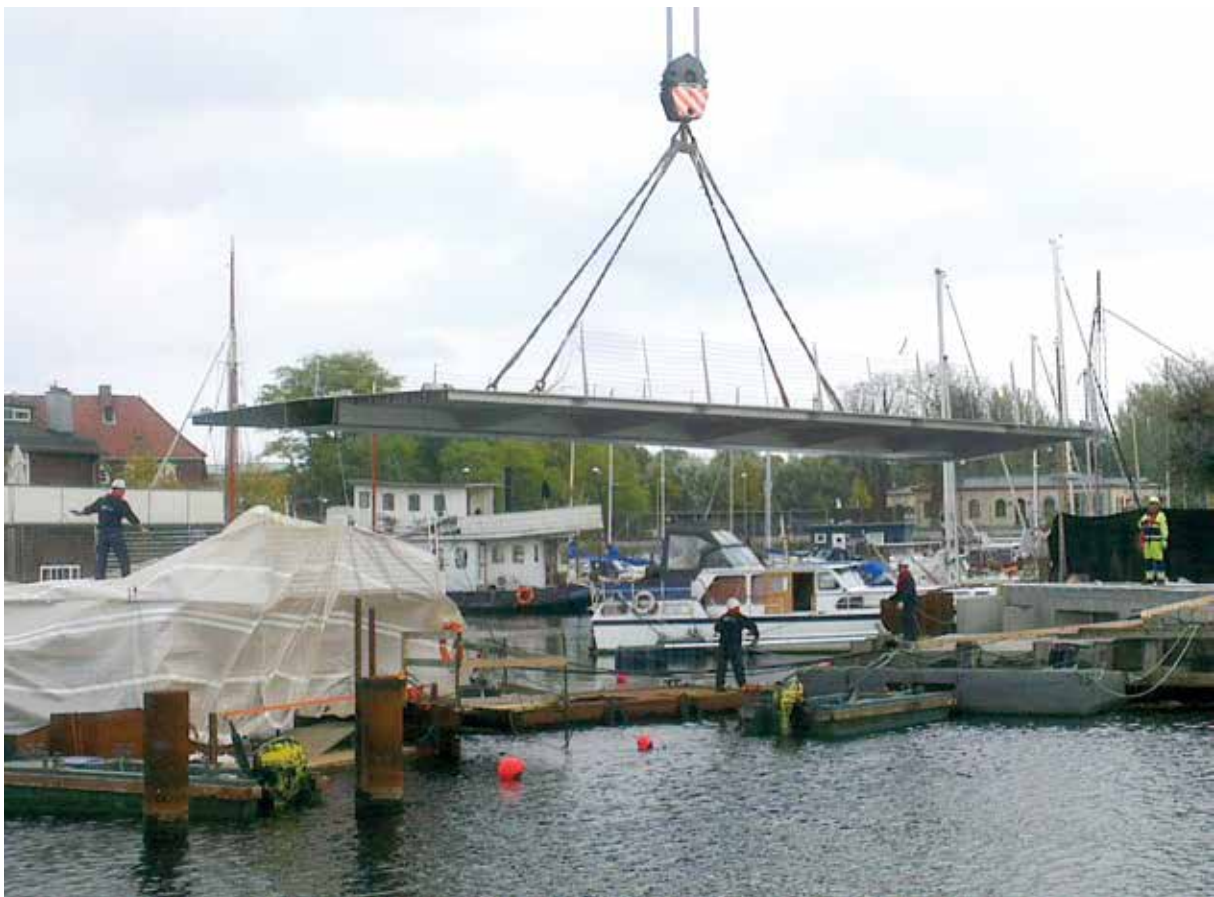
Bild 12: Montage der Brückenteile mittels Schwimmkran
