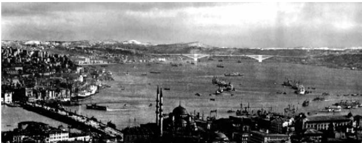
Bild 36: Spannbandbrücke über den Bosphorus
