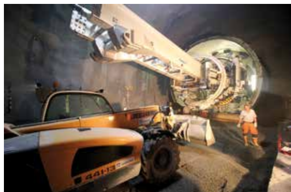
Bild 17: Doppelschildmaschine im Tunnel des neuen Wasserkraftwerks in Pfunds/Österreich (Foto: Robert Zobel)
