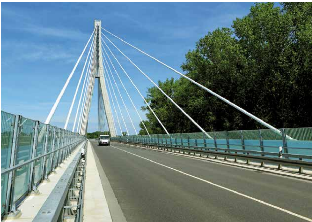
Bild 6: Elbauenbrücke Schönebeck, ausgezeichnet von Institution of Structural Engineers, London, 2014 (Foto: Rene Legrand, Rühn)
