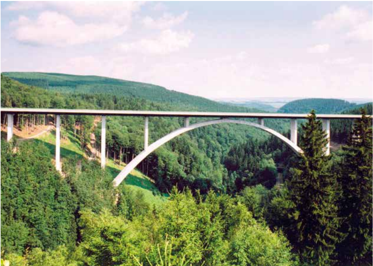
Bild 5: BAB A 71, Talbrücke Wilde Gera; Deutscher Brückenbaupreis 2006 in der Kategorie Straßen- und Eisenbahnbrücken (Foto: Foto Schüler, Zella-Mehlis)
