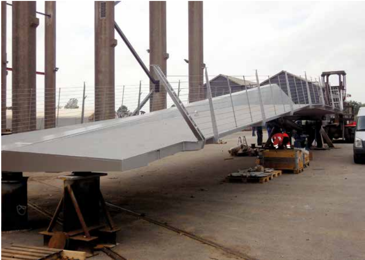
Bild 11: Fertigung der Brückenteile im Werk
