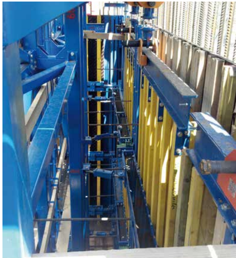
Bild 20: Arbeitsraum hinter der Innenschalung (© Hünnebeck Deutschland GmbH, Ratingen)
