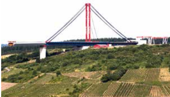
Bild 2: Überbau mit Hilfsspylon, Stand Juni 2015 (© LBM: Landesbetrieb Mobilität Trier, Rheinland-Pfalz)
