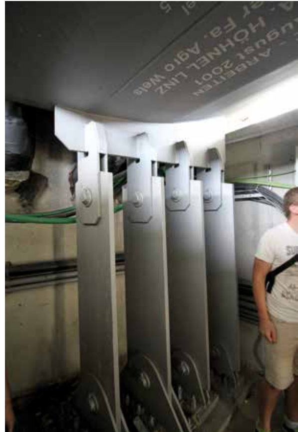
Bild 12: Rückverankerung des Makartsteges in Salzburg/Österreich (Foto: Robert Zobel)
