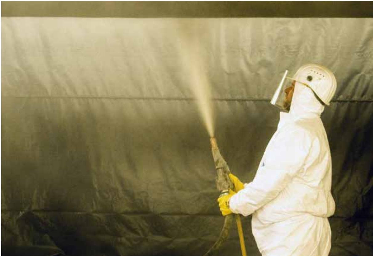
Bild 10: Sprühen des Feinbetons für eine Carbonbetonschicht
