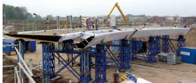
Bild 29: Realisation – Montage Brückendeck
