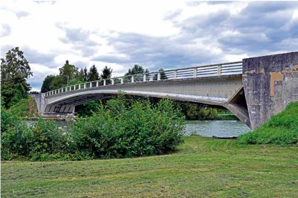
Bild 14: Freyssinet-Brücke in Changis-sur-Marne, erbaut 1950
