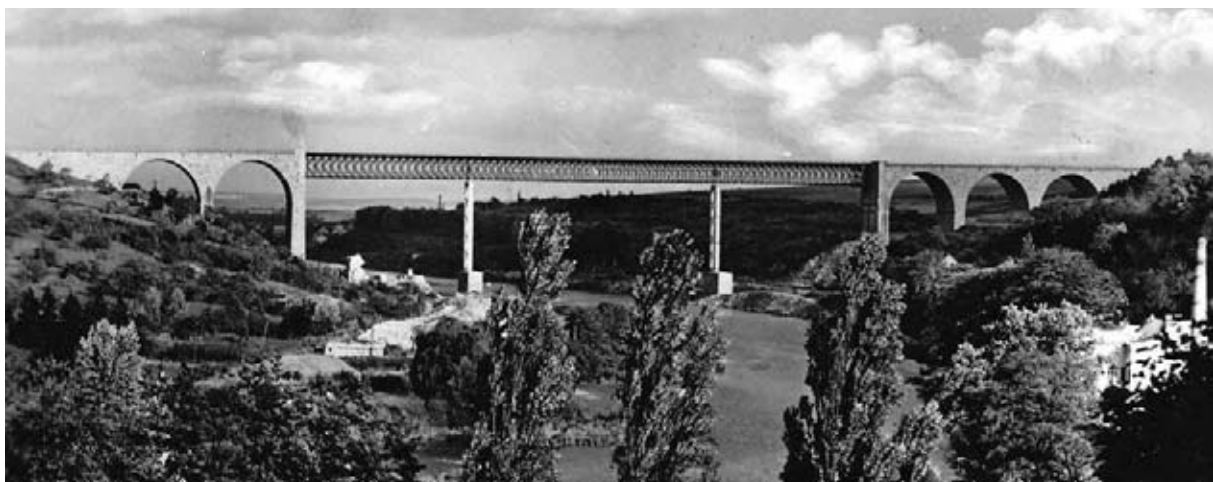
Bild 2: Lahntalbrücke mit Behelfsbrücke
