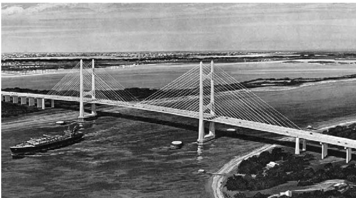
Bild 41: Dames Point Bridge Florida
