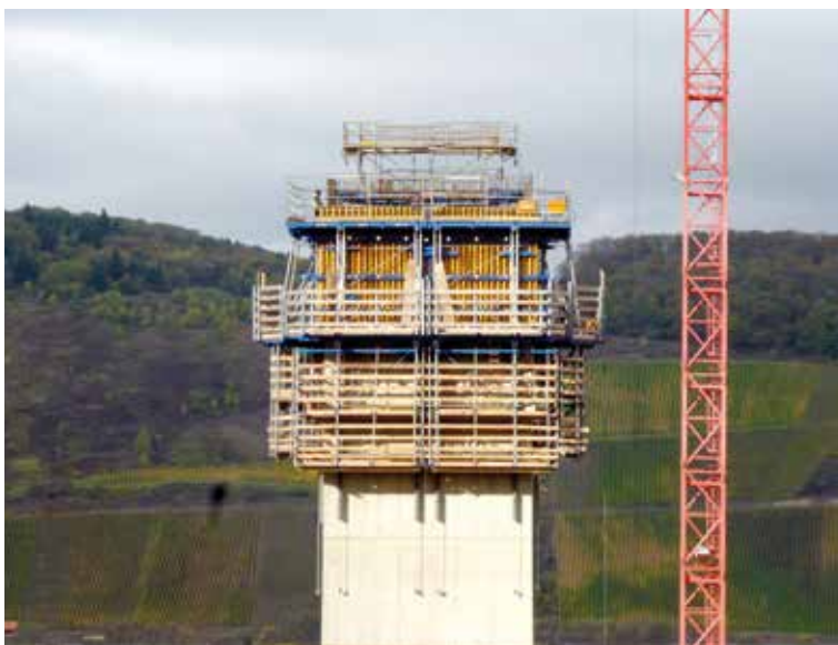
Bild 14: Selbstkletterbühnen im Bereich der Pfeilertaille (© Hünnebeck Deutschland GmbH, Ratingen)
