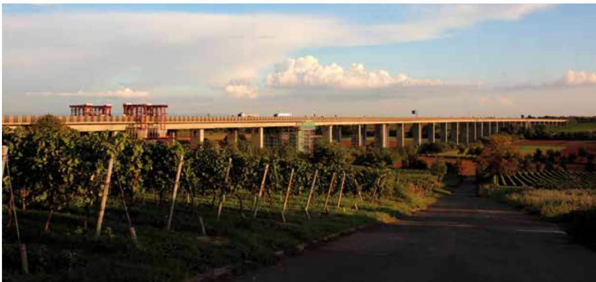
Bild 1: Talbrücke Pfeddersheim, Brückenansicht
