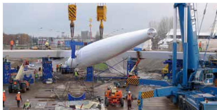
Bild 30: Realisation – Montage Pylon
