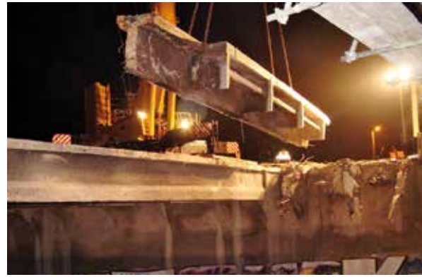
Bild 10: Abbruch der Brücke Pausaer Straße 2012 (Foto: Frank Rothkamm)
