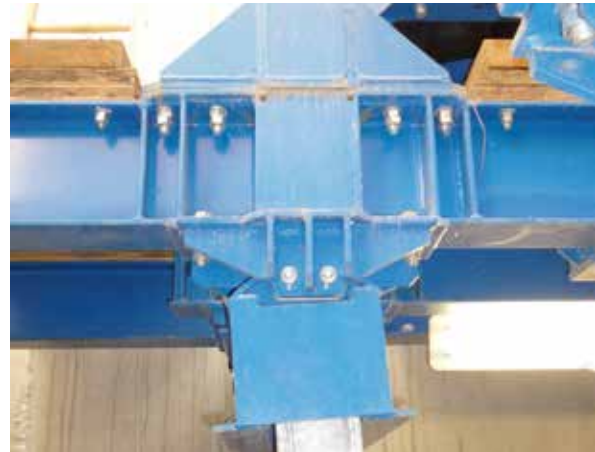
Bild 18: Rückansicht Drehlager unter Innenbühne (© Hünnebeck Deutschland GmbH, Ratingen)
