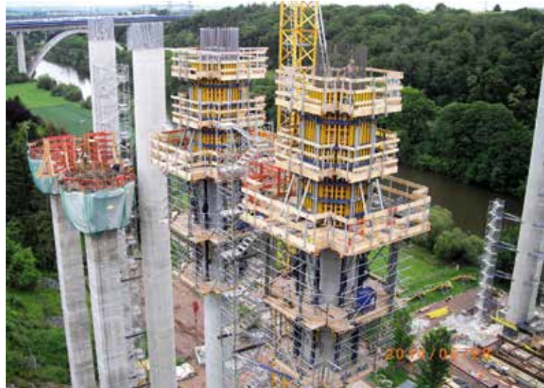
Bild 12: Pfeilerherstellung mit Kletterschalung und Gleitschalung (links)
