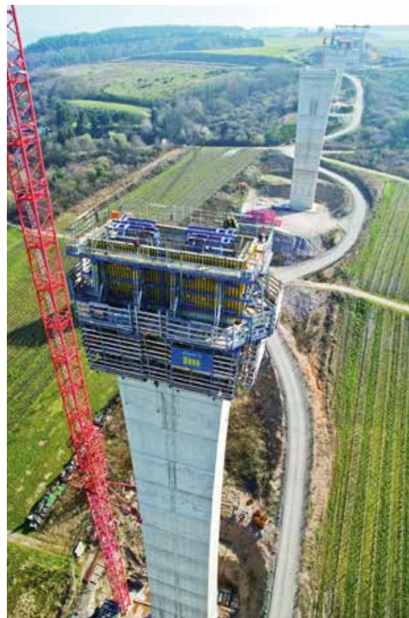
Bild 10: Kletterschalung am Pfeilerkopf (© Hünnebeck Deutschland GmbH, Ratingen)
