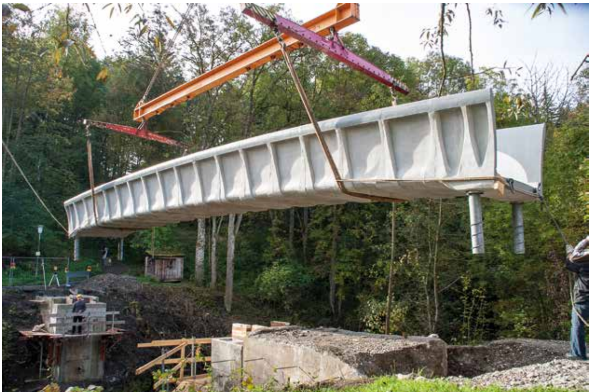
Bild 6: Brücke in Kempten – Einheben des kompletten Überbaus
