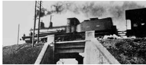
Bild 4: Frühe Eisenbetonbalkenbrücke nach dem System Hennebique für Eisenbahnverkehr [6], dort verwiesen auf [13]
