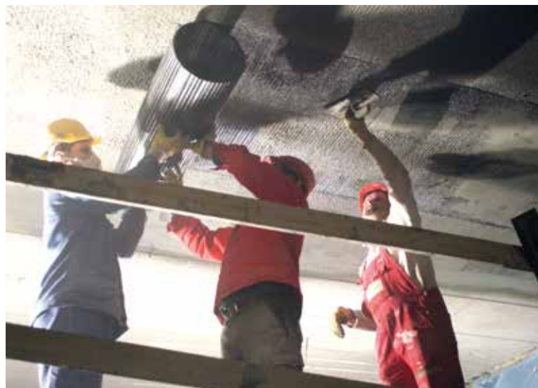
Bild 7: Verstärkung einer Deckenplatte, Einbau des Textilbetons über Kopf im Sprühverfahren (Foto: Frank Schladitz)
