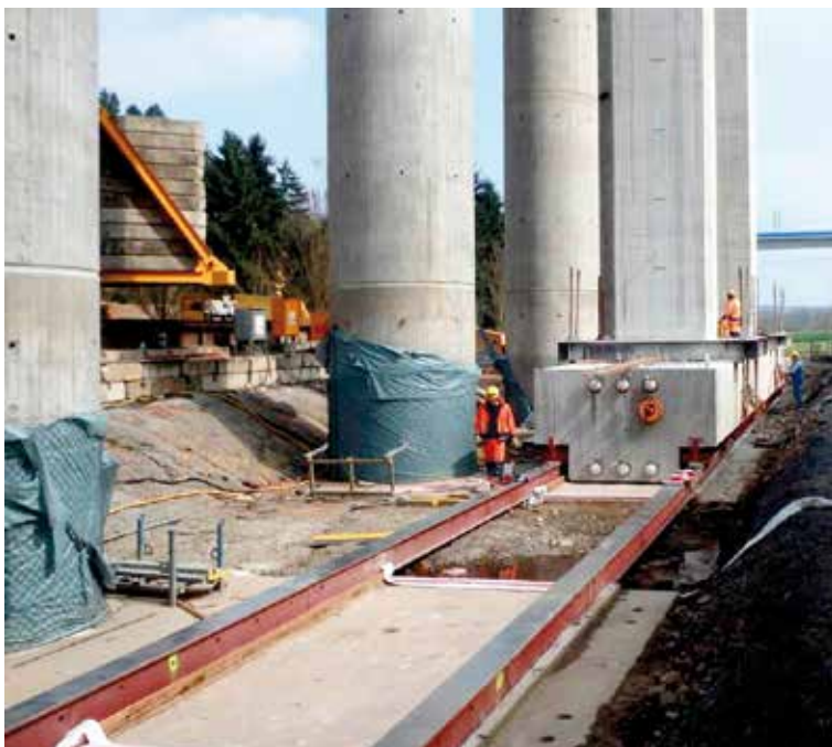
Bild 14: Querverschub der Hilfspfeiler
