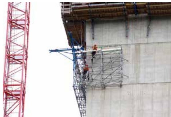
Bild 26: Endmontage der Gerüstkuben durch Industriekletterer (Gerüstplanen für Einbau noch aufgerollt)
