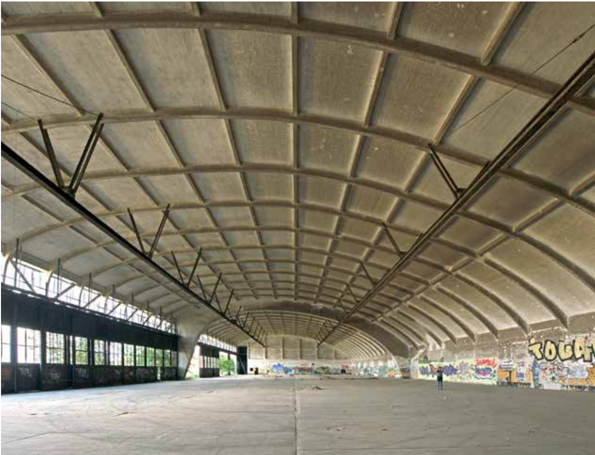
Bild 7: Flugzeughalle in Werneuchen
