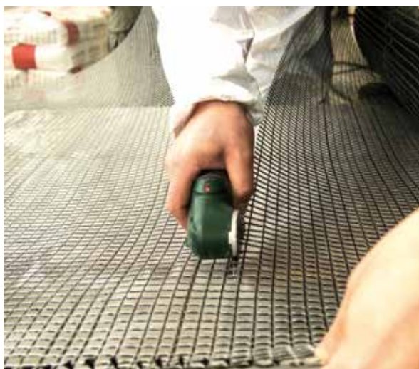
Bild 9: Händisches Zuschneiden der Bewehrung, hier: mit einem elektrischen Rollenmesser (Foto: Harald Michler)
