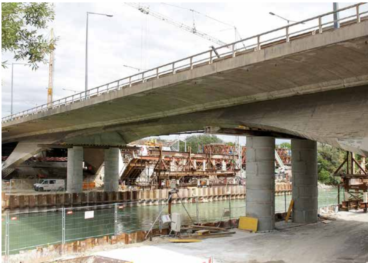
Bild 5: Noch bestehende Erdberger Brücke, Wien/Österreich
