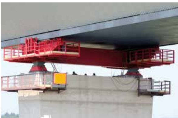
Bild 3: Verschiebbalken auf Pfeiler Achse 09 (© LBM: Landesbetrieb Mobilität Trier, Rheinland-Pfalz)
