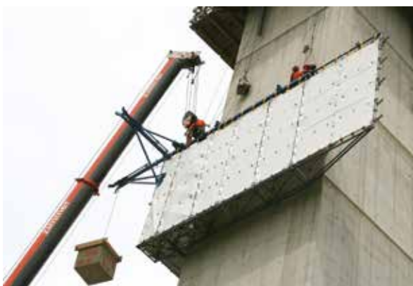
Bild 25: Einheben eines Windabweisers mit Kontergewicht
