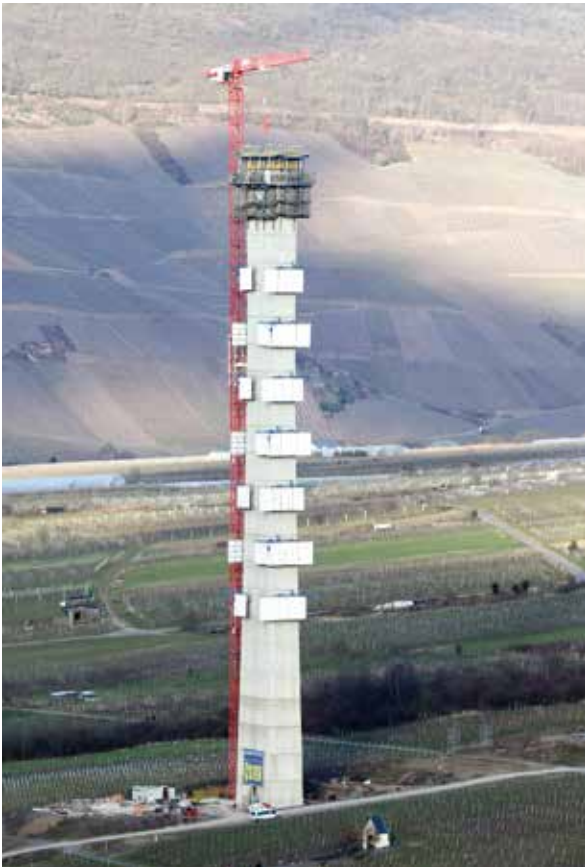
Bild 27: Windabweiser am Pfeiler Achse 6 (©LBM: Landesbetrieb Mobilität Trier, Rheinland-Pfalz)
