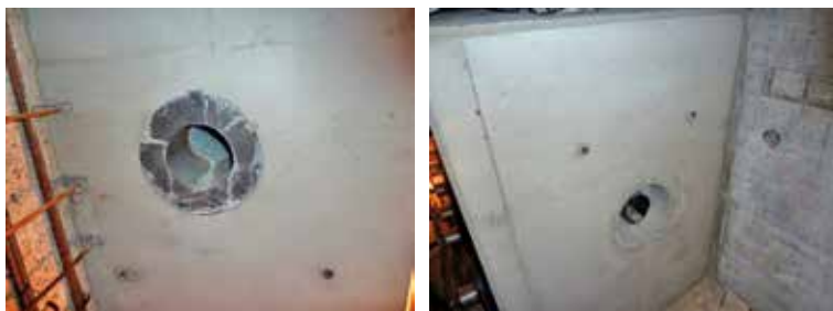
Bild 14: Endverankerungen im Lasteinleitungsblock (Fotos: Michael Buschlinger, BBV)
