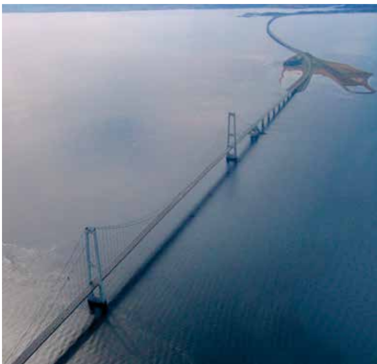
Bild 5: Hängebrücke über den Ostteil des Großen Belts, entworfen von COWIconsult
