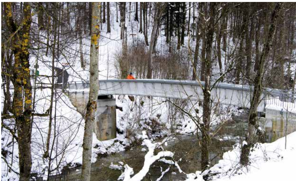
Bild 5: Brücke in Kempten
