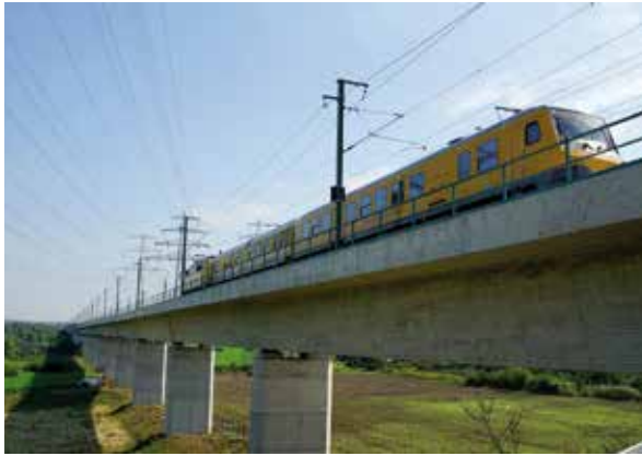
Bild 22: Saale-Elster-Talbrücke bei Halle/Saale (Foto: Sebastian Wilhelm)
