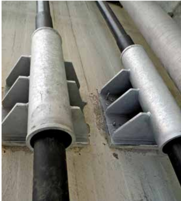
Bild 18: Umlenkung Typ F, Stahlumlenkteil mit innenliegenden Hülse (Zeichnung und Foto: Annette Jarosch, BBV)
