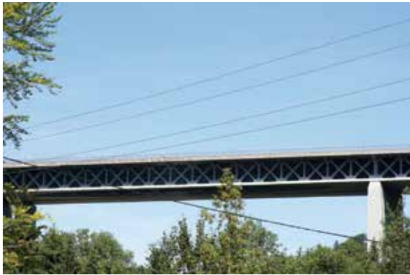
Bild 13: Mangfallbrücke – eine Spannbetonbalkenbrücke von Ulrich Finsterwalder bei Weyarn/Deutschland (Foto: Sebastian Wilhelm)
