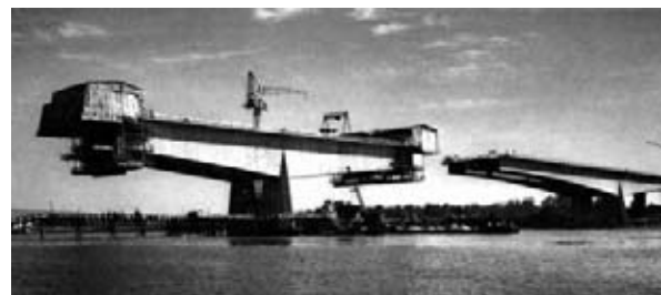
Bild 27: Freivorbau der Brücke Bendorf
