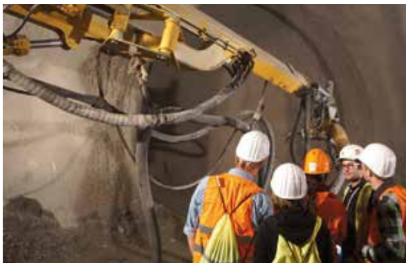
Bild 8: Tunnelbau im Sprengvortrieb bei der Tunnelkette Granitztal, Deutsch-Grutschen/Österreich (Foto: Sebastian Wilhelm)
