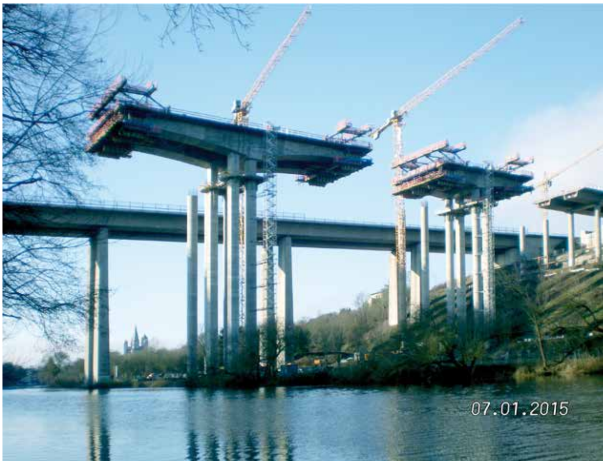
Bild 16: Freivorbau am nördlichen Lahnufer
