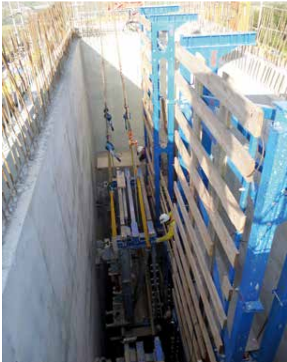
Bild 13: Ausbau Innenbühne am Pfeilerkopf (© Hünnebeck Deutschland GmbH, Ratingen)
