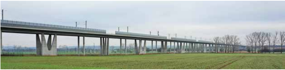
Bild 2: Eisenbahn-Hochgeschwindigkeitsbrücke Gänsebachtal, entworfen von Jörg Schlaich
