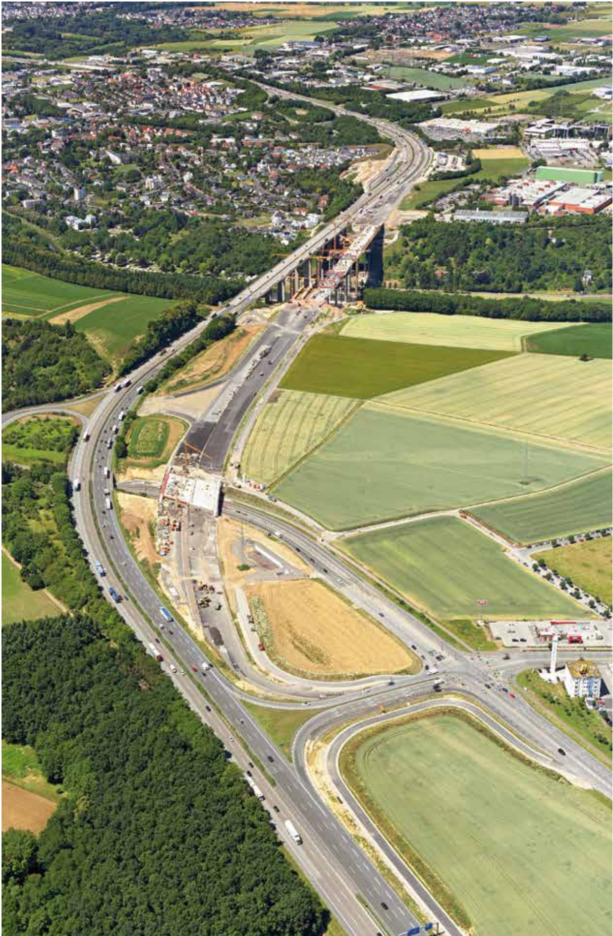
Bild 19: Blick von der Anschlussstelle Limburg-Süd nach Norden
