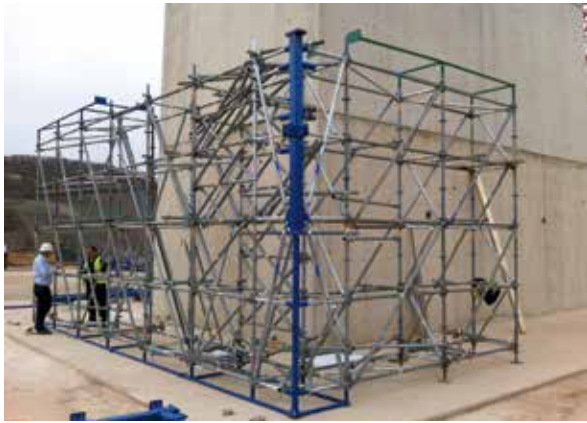
Bild 24: Montage der Windabweiser am Boden (© Hünnebeck Deutschland GmbH, Ratingen)
