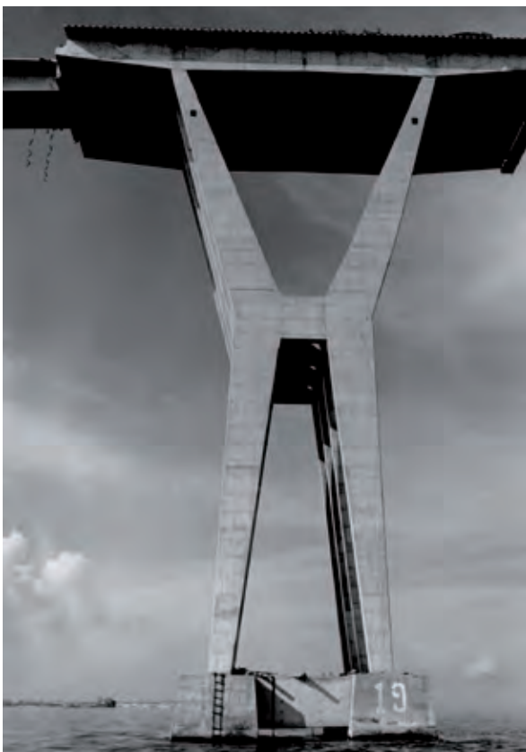
Bild 22 Ansicht der von Riccardo Morandi entworfenen Stützen für die Brücke über den Maracaibo-See Foto: Deutsches Museum
