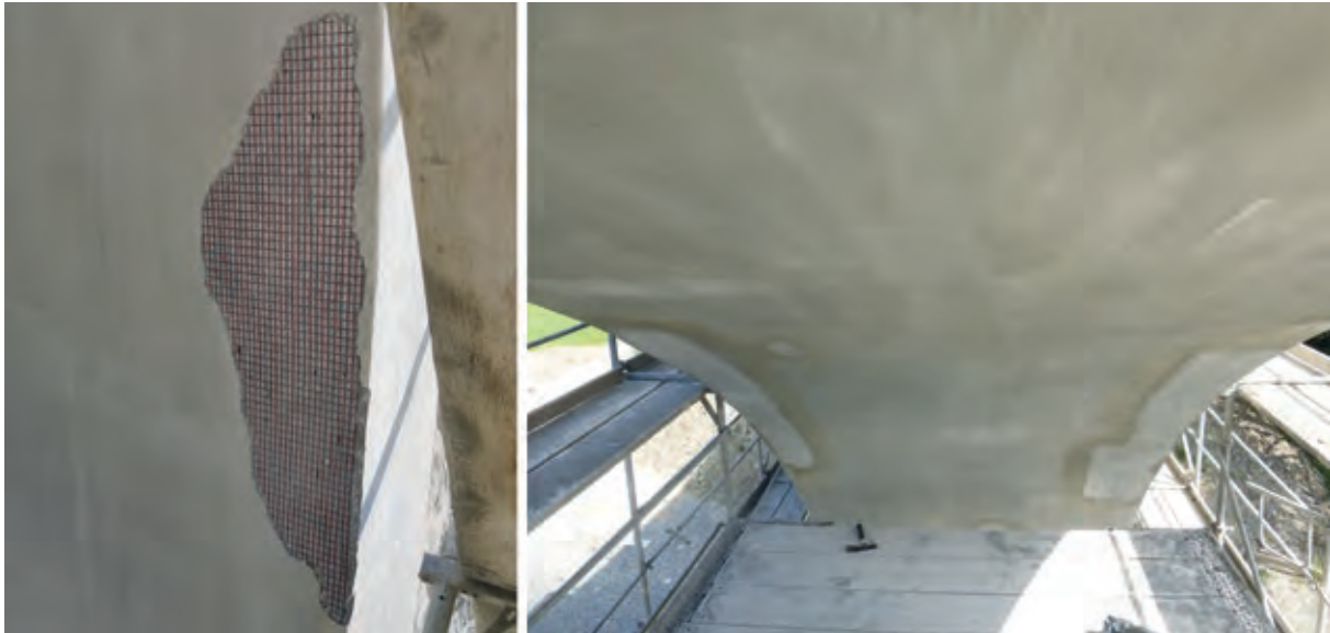
Bild 7 Lessons Learnt – links freigestemmt und rechts instandgesetzte Hohlstellen am Bogen 2 Fotos: Ammar Al-Jamous und Karsten Uhlig
