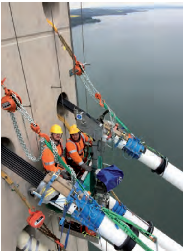
Bild 16 Montage der Seile
