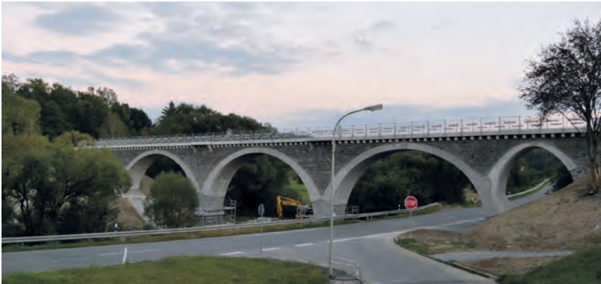
Bild 9 Ansicht Nord der fertig instandgesetzten Brücke
