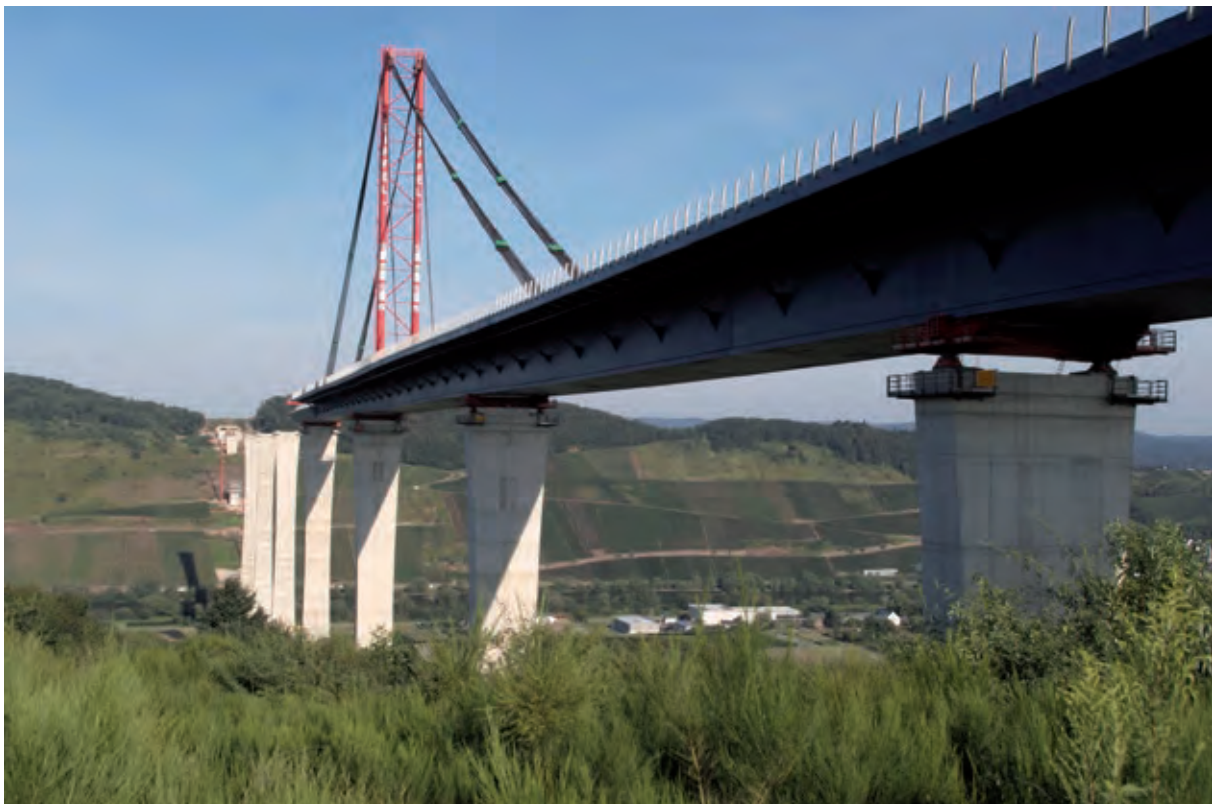
Bild 2 Hochmoselübergang – Bauzustand im August 2016
