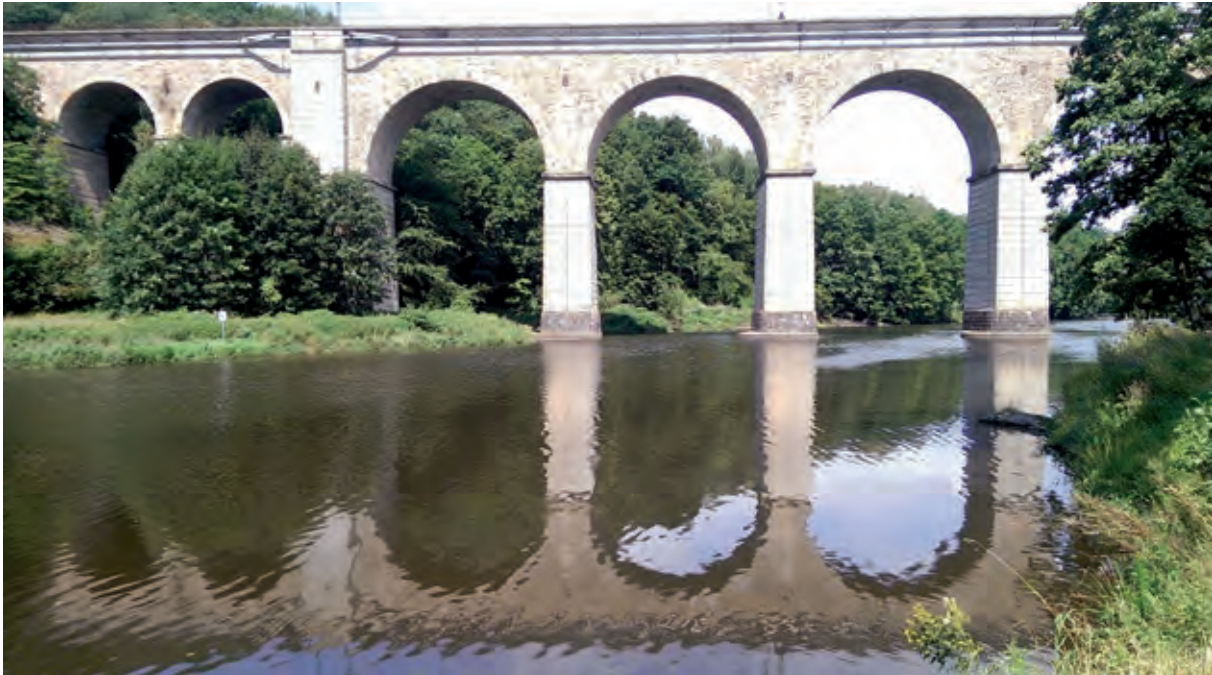
Bild 1 Viadukt Limmritz bei km 29,981
