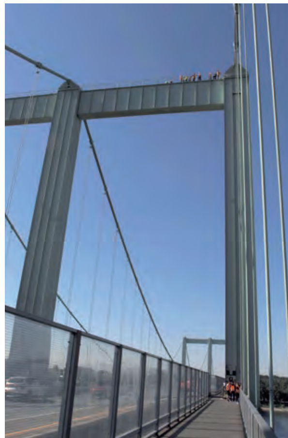
Bild 6 Besichtigung des Pylons der Brücke Köln-Rodenkirchen Foto: Oliver Steinbock
