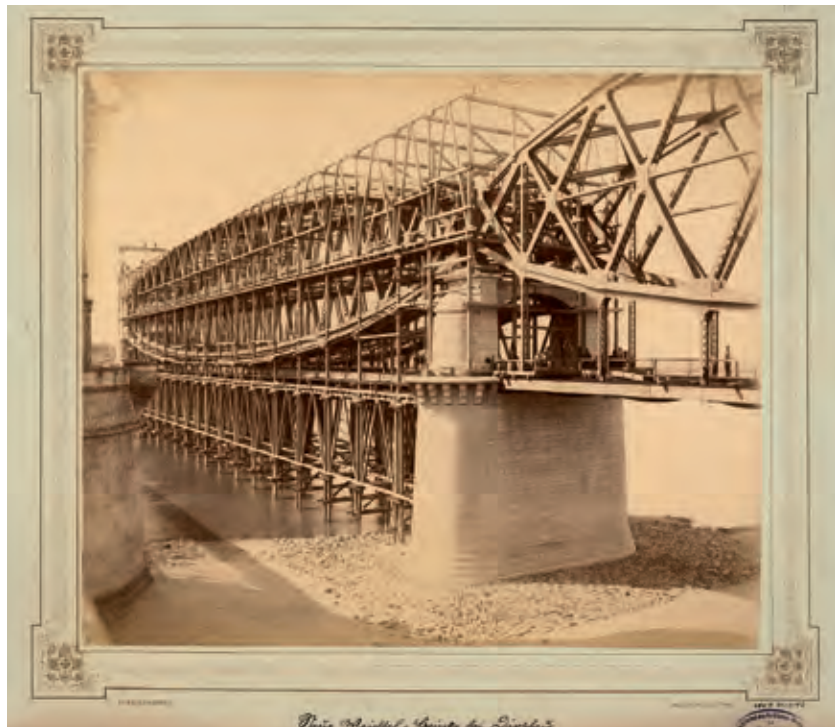
Bild 6 Neue Weichselbrücke, Dirschau – Ansicht vor Fertigstellung 1891
