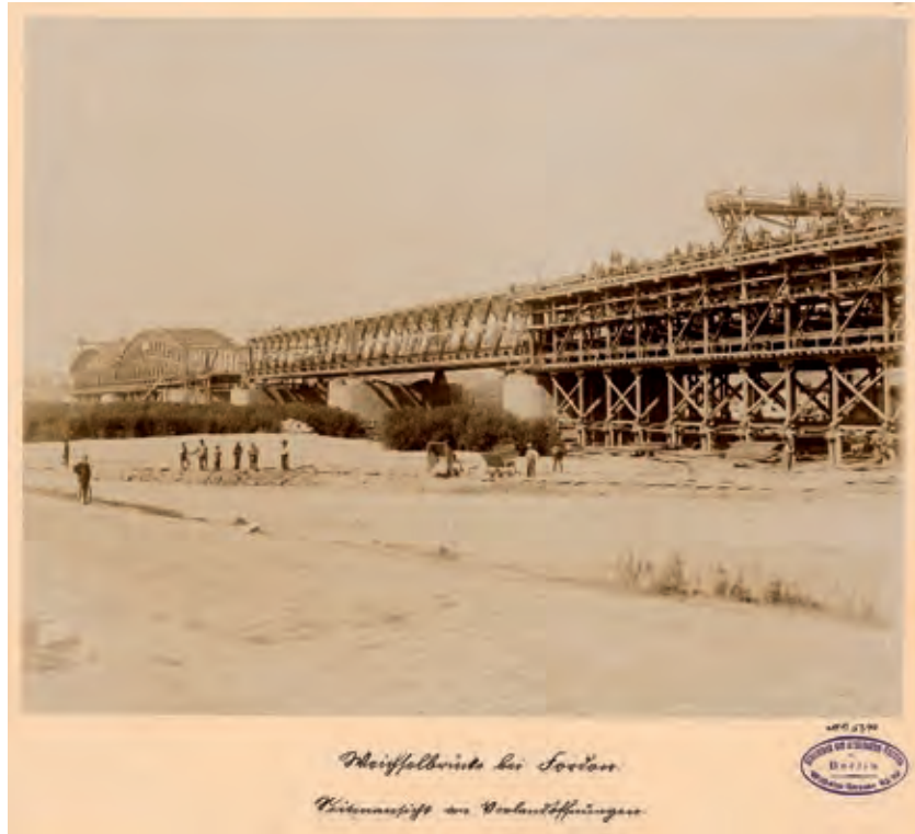
Bild 8 Weichselbrücke (Rudolf-Modrzejewski-Brücke), Fordon – Seitenansicht der Vorlandbrücke während der Errichtung
