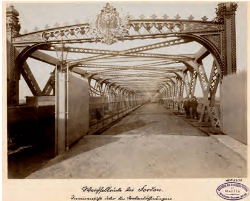
Bild 9 Weichselbrücke (Rudolf-Modrzejewski-Brücke), Fordon – Blick durch den Überbau der Vorlandbrücke
