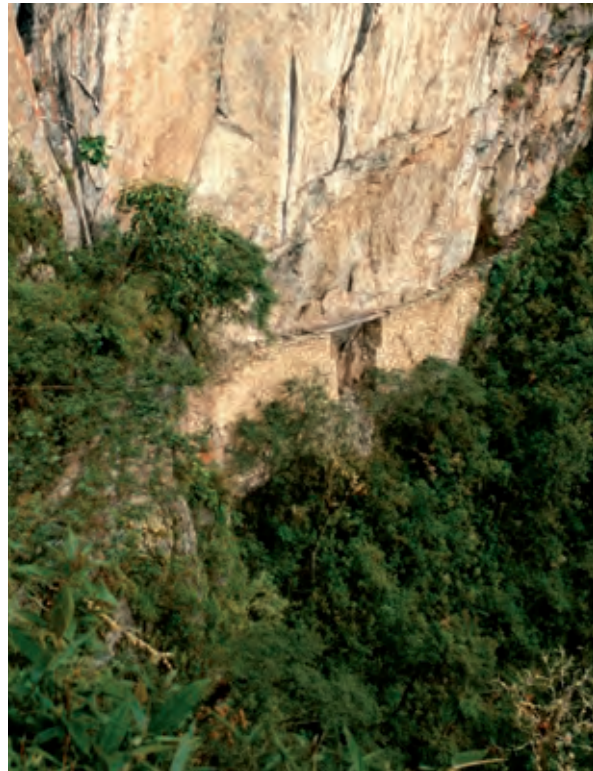
Bild 3 Holzbohlenbrücke auf dem Zugangsweg zur Festung von Machu Picchu (Peru)
