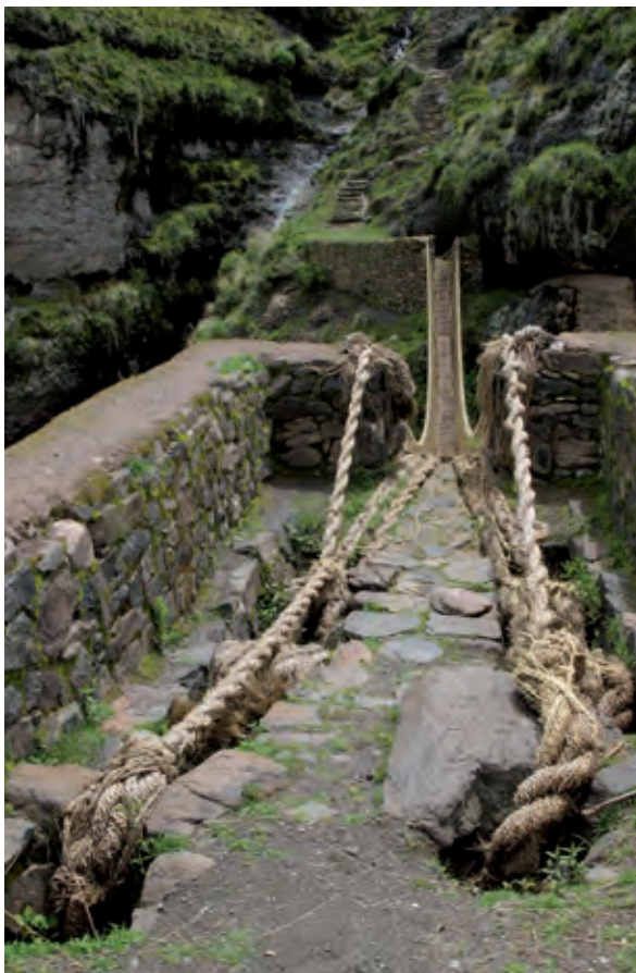
Bild 10 Die hangseitige Verankerung der Seile bei der Q'eswachaca-Brücke Foto: Dirk Bühler
