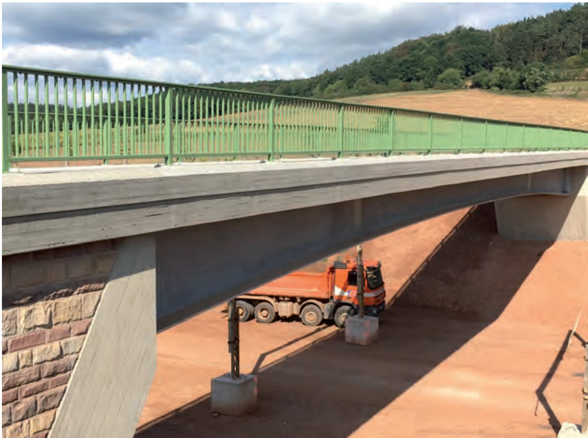
Bild 1 Feuerverzinkung im Brückenbau – Pilotprojekt Überführungsbauwerk „Am Weinberg“ über die A 44 bei Waldkappel/Kassel
