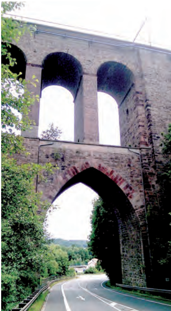
Bild 2 Viadukt Diedenmühle bei km 34,271
