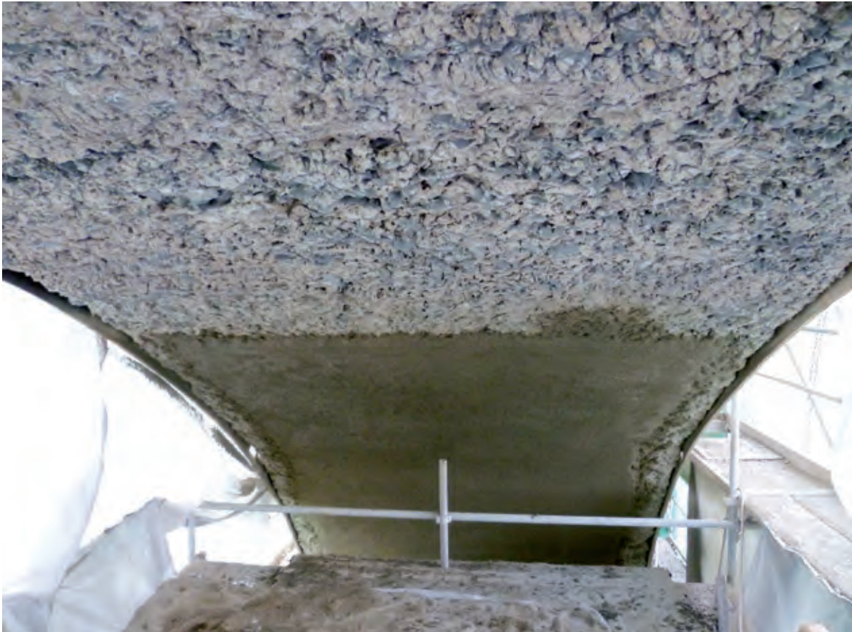
Bild 3 Auftrag des Spritzmörtels auf mittels HDW vorbereiteter Betonoberfläche
