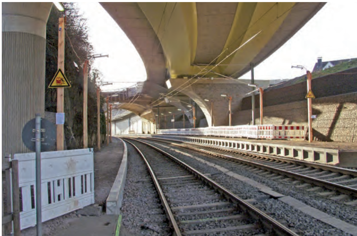
Untersicht Brücke Hüttentalstraße
