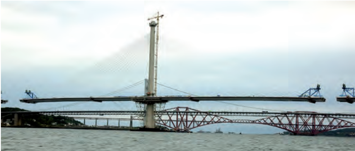
Bild 11 Mittlerer Pylon mit maximalen Kragarmen
