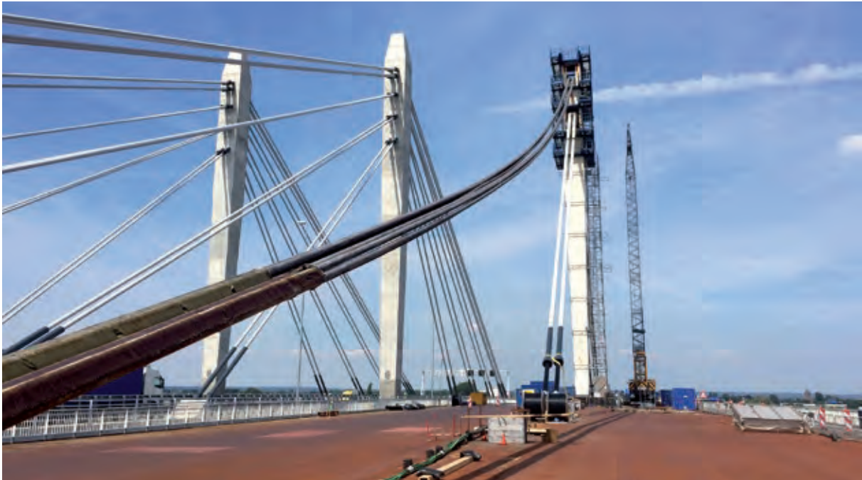
Bild 7 Ewijkbrücke über den Rheinarm Waal
