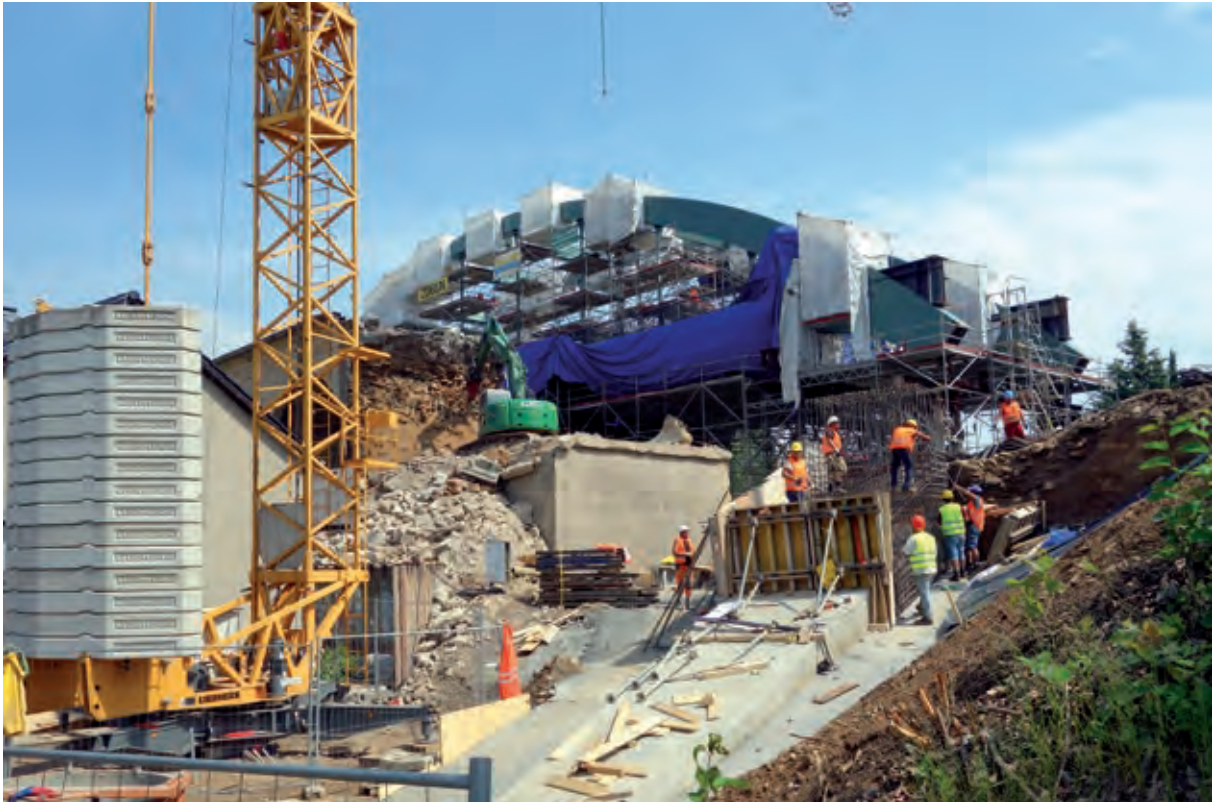
Bild 13 Baustellenimpression: Abbruch, Stahlbetonarbeiten und Stahlbauarbeiten am Überbau gleichzeitig Foto: Thomas Bösche
