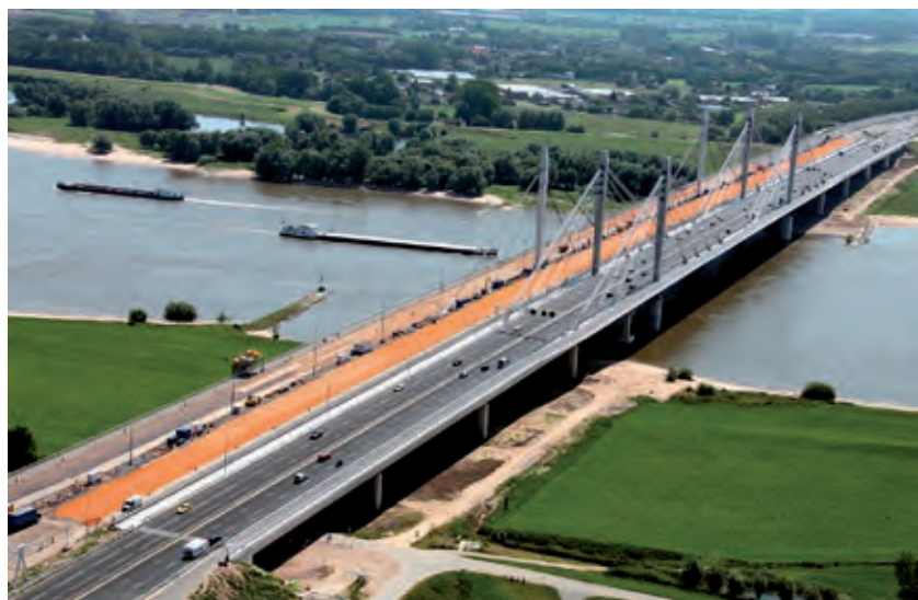
Bild 8 Bestandsbrücke (links) und neuer Überbau (rechts)
