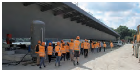
Bild 1 Schiersteiner Brücke – Vorfertigung des einzuschwimmenden Stahlbauteils an Land Foto: Oliver Steinbock
