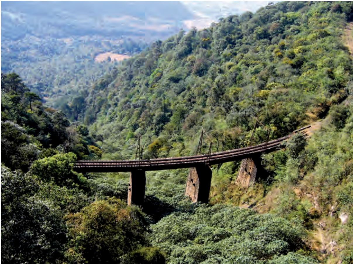
Bild 17 Die Wimmer-Brücke von der darüber liegenden Autobahn aus gesehen
