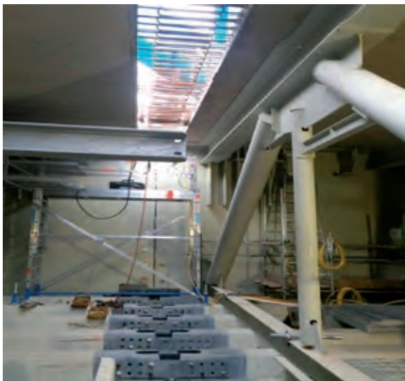
Bild 10 Montagestoß mit Laschenverbindungen unten und Betonierfuge oben Foto: FCBC
