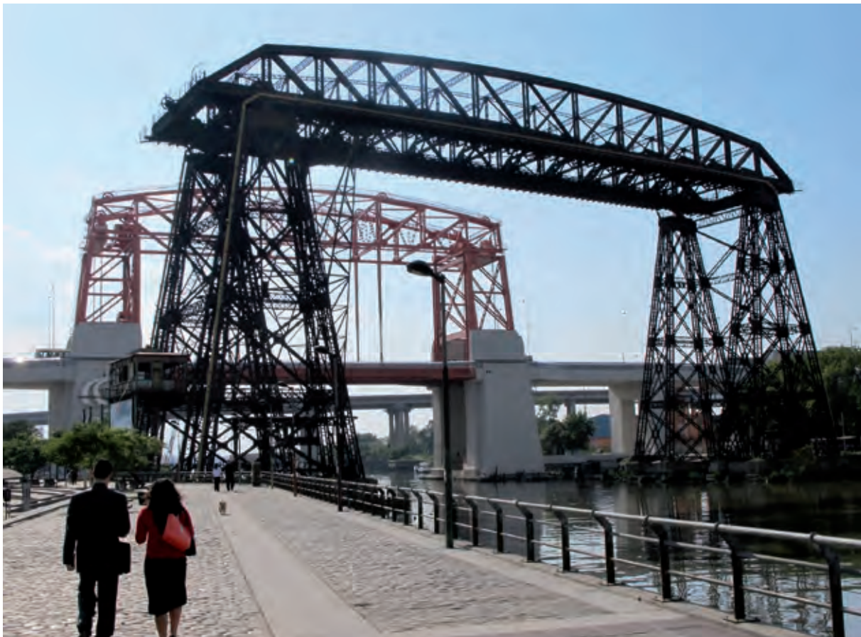
Bild 15 Die Schwebefähre Nicolás Avellaneda in Buenos Aires (Argentinien) wurde 1914 erbaut und ist eins der acht noch bestehenden Beispiele für diesen Brückentyp. Sie ist heute restauriert und wieder funktionsfähig. Foto: Dirk Bühler
