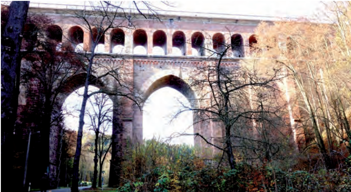
Bild 3 Viadukt Heiligenborn bei km 36,055
