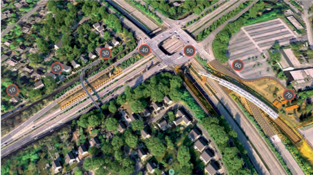
Bild 13 Vogelperspektive – Taktschieben bis Hilfsstütze im Trog der A44
