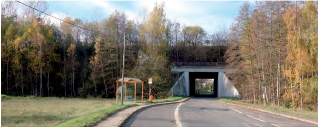
Bild 8 Das 1991 verfüllte Viadukt Crossen
