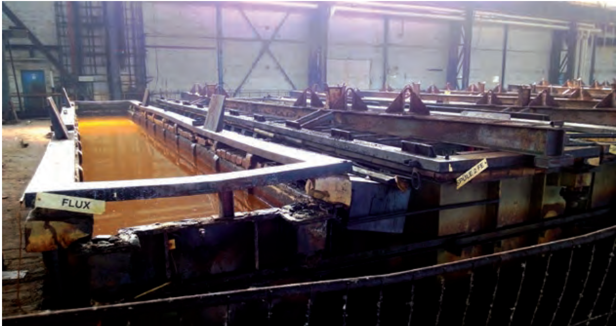
Bild 1 Tauchbecken zur Vorbehandlung in einer Verzinkerei
