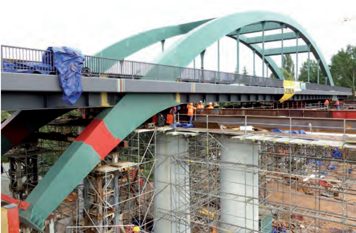
Bild 14 Querverschub
