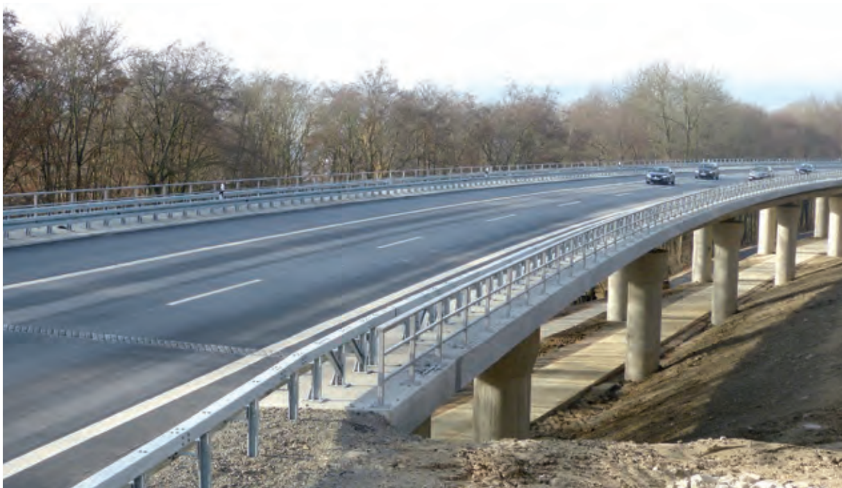
Seitenansicht der Hangbrücke Würgau
