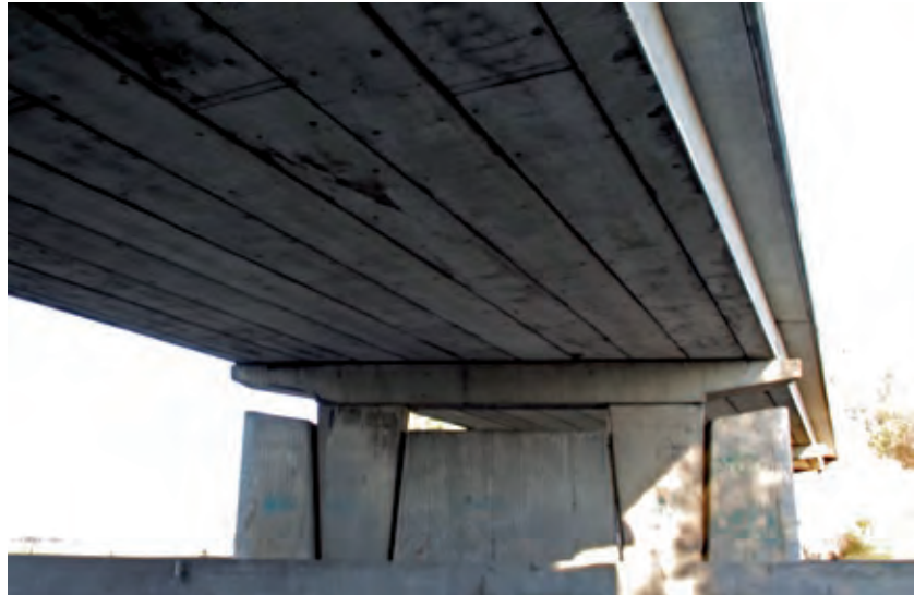
Bild 9 Untersicht einer 4feldrigen Balkenreihenbrücke über die BAB A 14 zwischen Wendischbora und Nossen (SÜ K8052)
