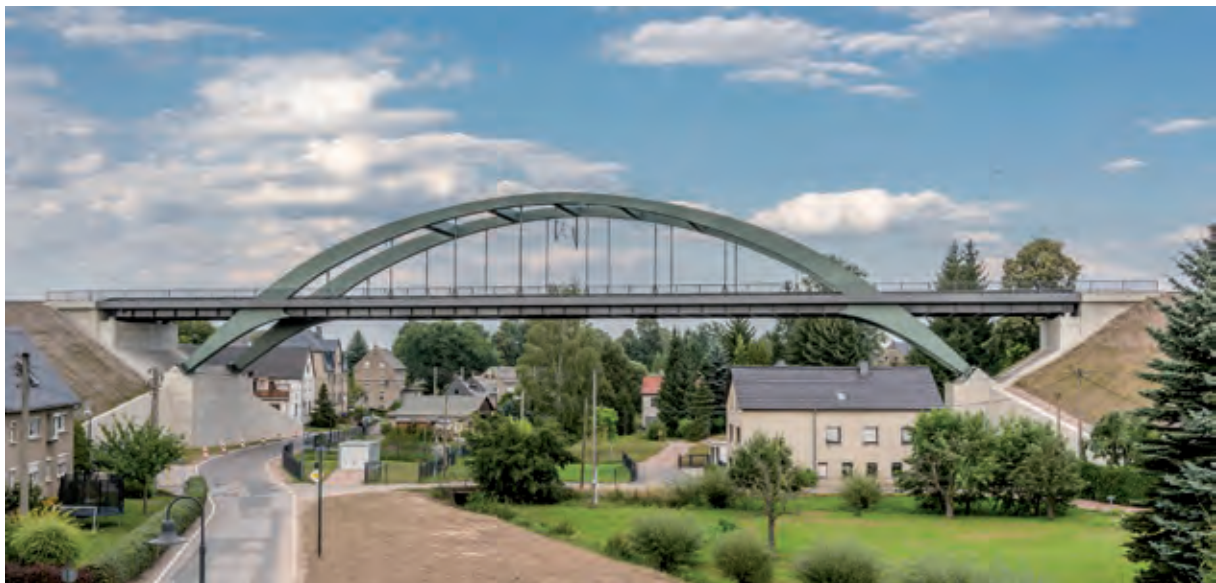
Bild 15 Die neue Eisenbahnbrücke nach Fertigstellung
