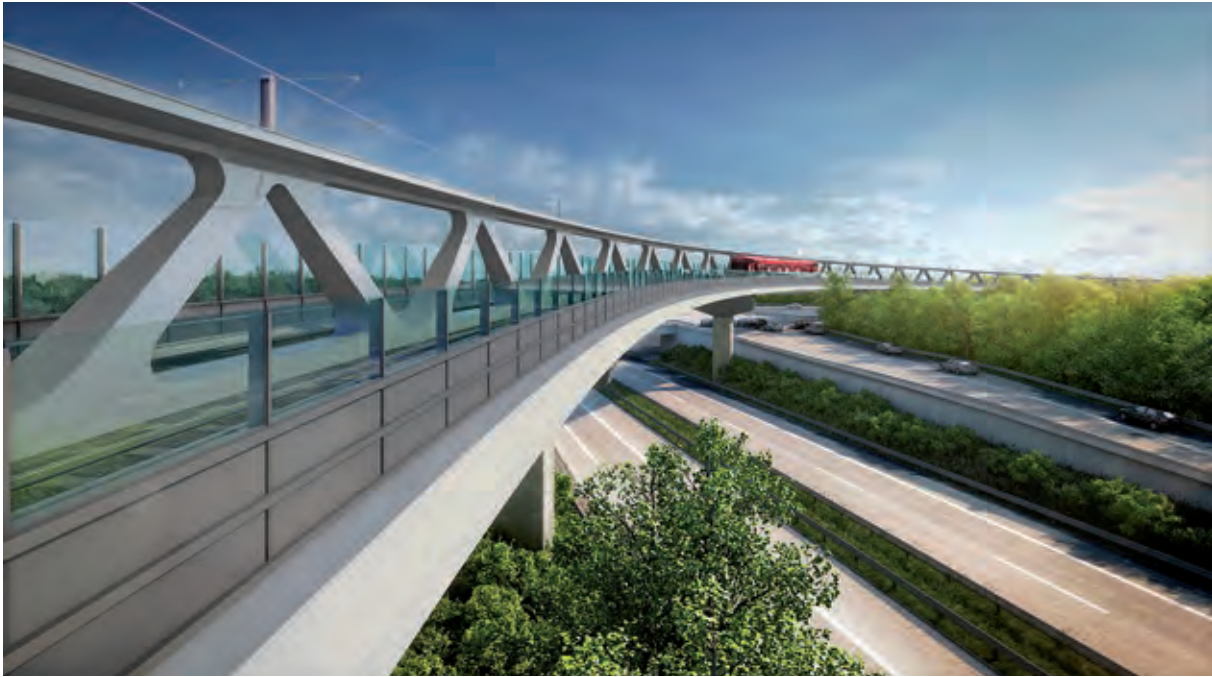
Bild 5 Blick entlang der Brücke über den Nordstern
