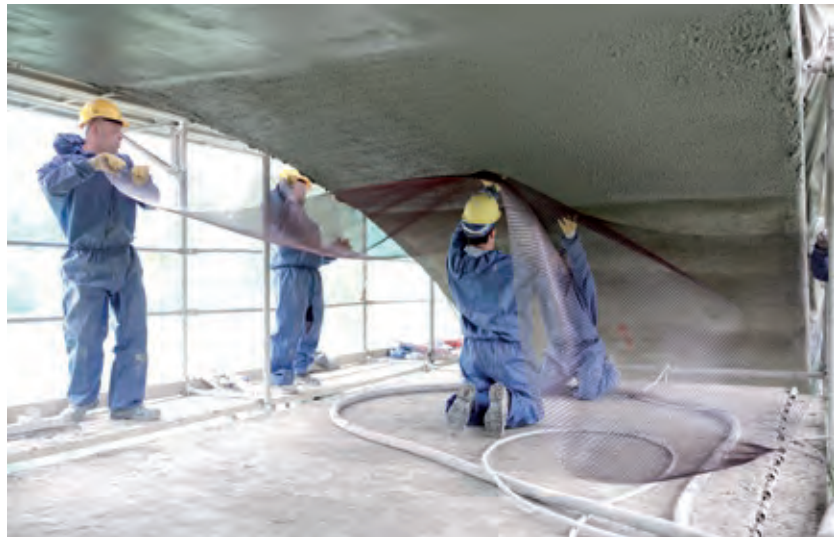
Bild 4 Einbau der Carbonbewehrung in die frisch gespritzte Feinbetonschicht Foto: C 3 – Jörg Singer
