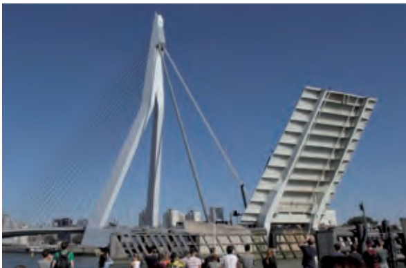
Bild 8 Hebevorgang der Klappbrücke Erasmusbrücke – Rotterdam Foto: Oliver Steinbock
