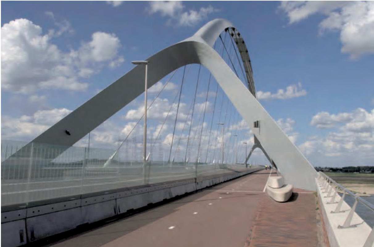
Bild 14 De Oversteek in Nijmegen – Hauptfeld mit Bogentragwerk
