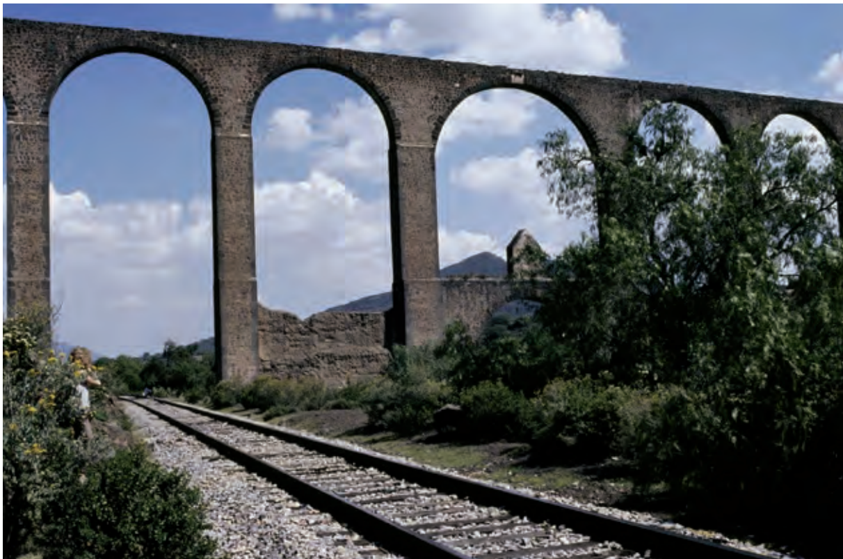
Bild 13 Ansicht der Hauptbögen des Aquädukts von Otumba und Zempoala; Reste des Adobe-Lehrgerüsts sind zwischen den Pfeilern noch zu erkennen. Foto: Dirk Bühler
