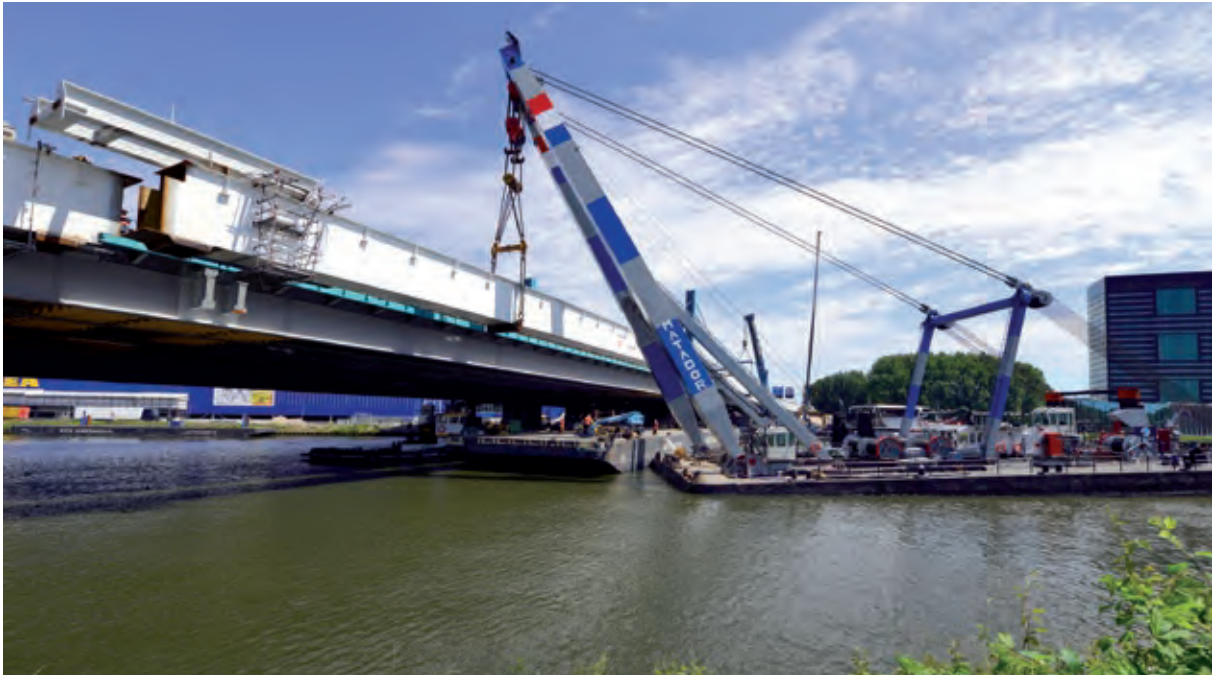
Bild 10 Einheben eines Abfangträgers
