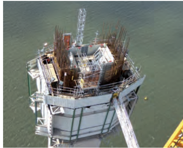
Bild 8 Herstellung der Pylone mit äußerer Kletterschalung und innenliegender Ankerbox
