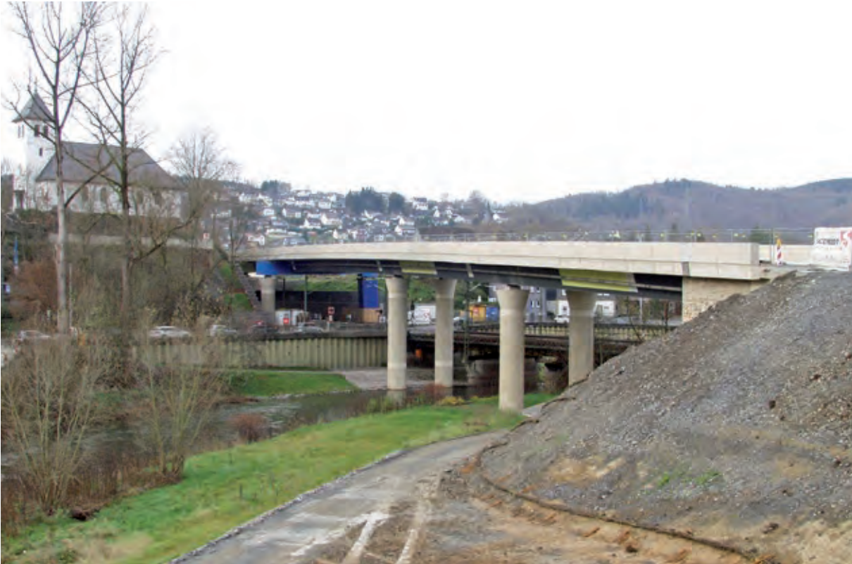
Seitenansicht Brücke Maccostaße
