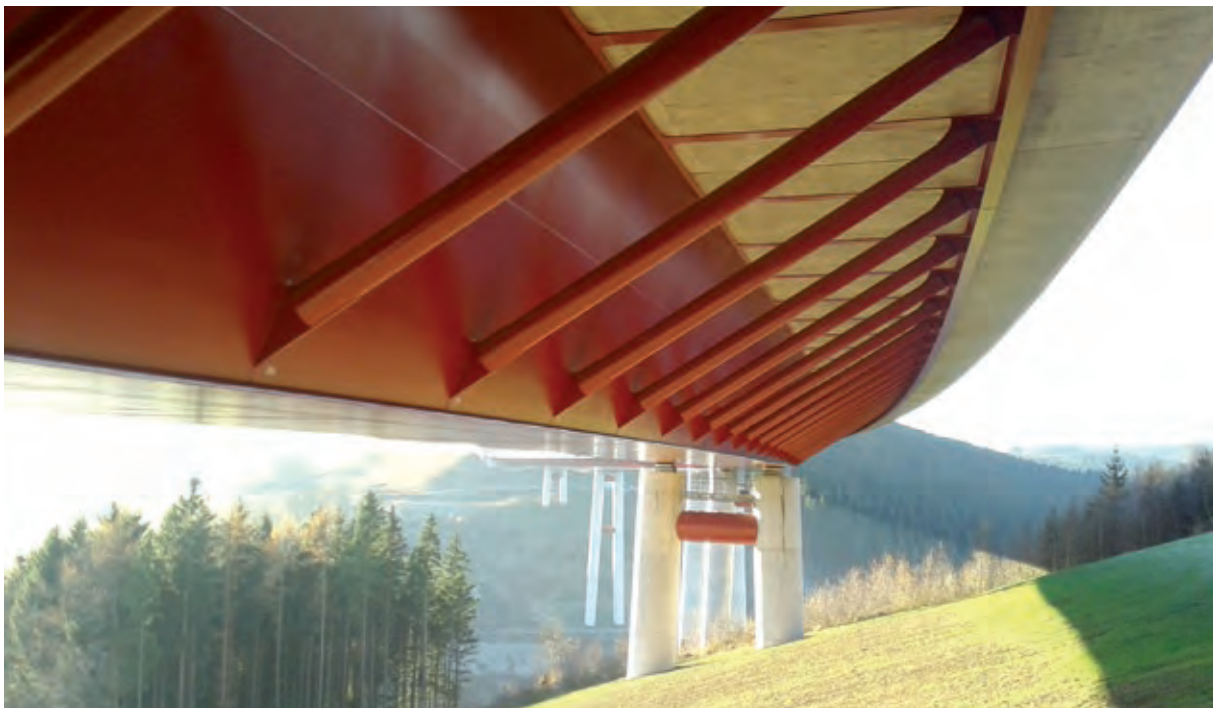
Untersicht der Talbrücke Nuttlar
