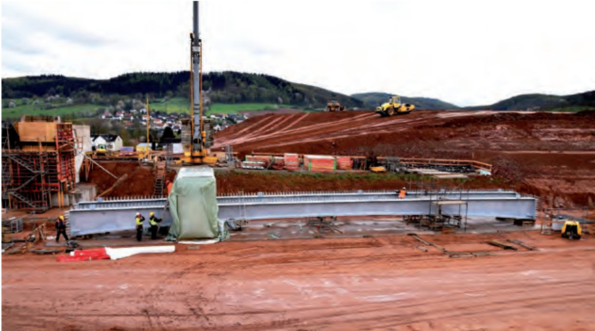
Bild 8 Vormontage auf der Baustelle
