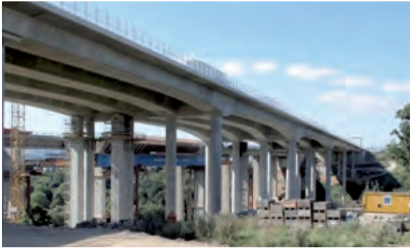
Bild 5 Neue Lahntalbrücke Foto: Oliver Steinbock
