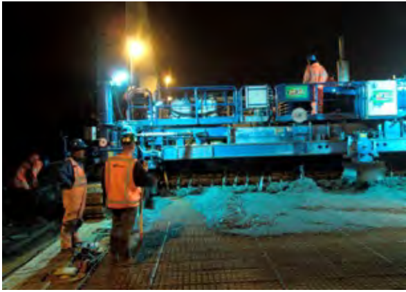
Bild 4 Einbau der Betonverstärkung
