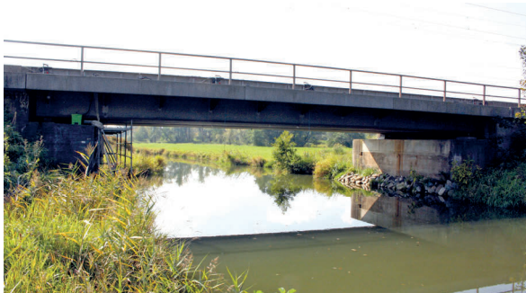
Bild 7 Seitenansicht der Eisenbahnüberführung über die Schmutter bei Augsburg
