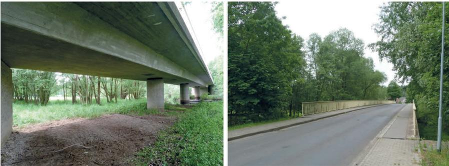
Bild 4 Spannbetonbrücke als Durchlaufträger
