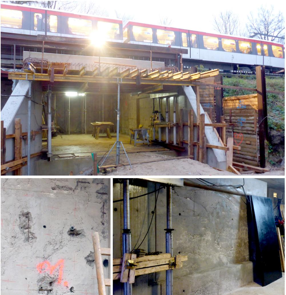
**Bild 2:** Übersichtsfoto der Baustelle und exemplarische Detailfotos der visuell erkennbaren Schäden
