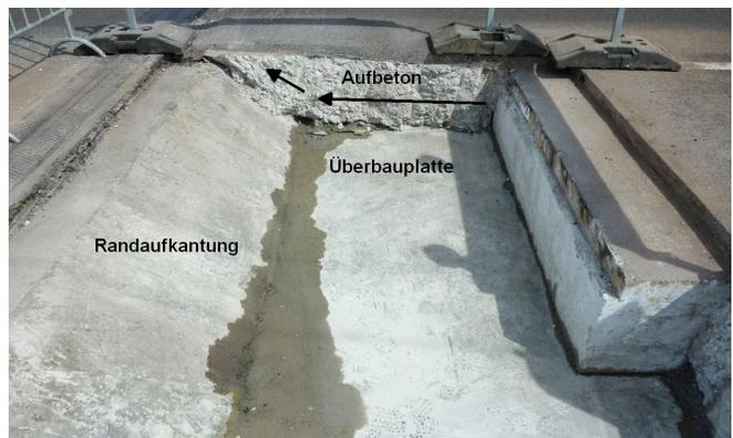
Bild 5: Überbaurandbereich nach teilweisem Ausbau des Aufbetons
