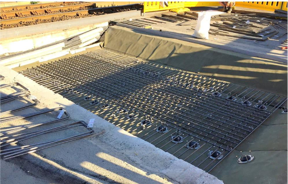
Bild 6: Einbau ‚Verankerungsblock‘ mit Tellerankern und unterer Bewehrungslage
