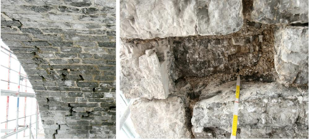
**Bild 5:** Schäden am Loisach-Viadukt; links: Stirnringrisse hinter der Stirnvormauer im Hauptgewölbe, rechts: herausgefallenes Steinfragment der Verblendung
