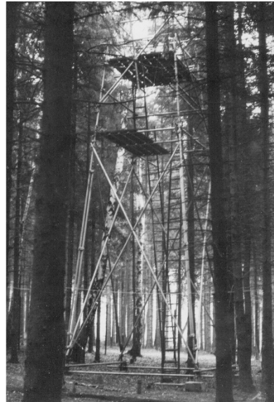
Messturm einer Energiebilanzstation, 1970er Jahre
