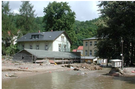
→starke Beschädigung des Gebäudes Pienner Str. 9, Zerstörung des Messfeldes
