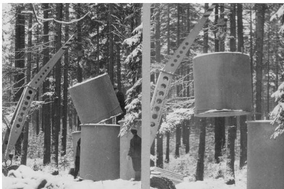
Bau einer Lysimeteranlage neben dem Wildacker, 10.01.1964
