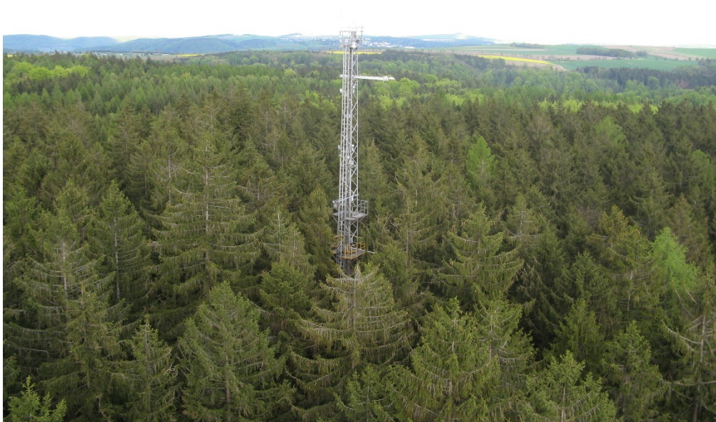
Ankerstation Tharandter Wald, Messturm aktuell (2012)
