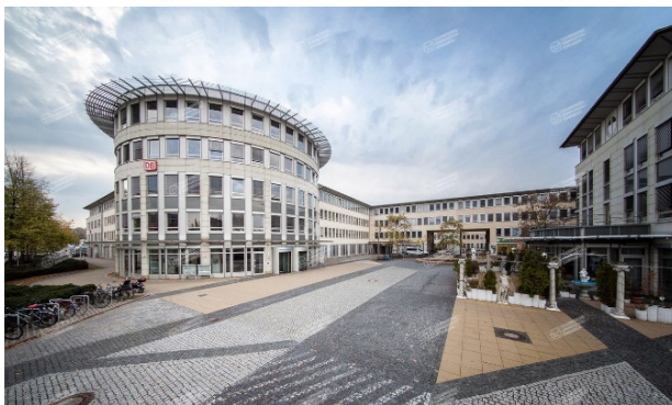
Chemnitzer Str./Falkenbrunnen (2003-2006) (Foto: Eisfeld, TU Dresden)
