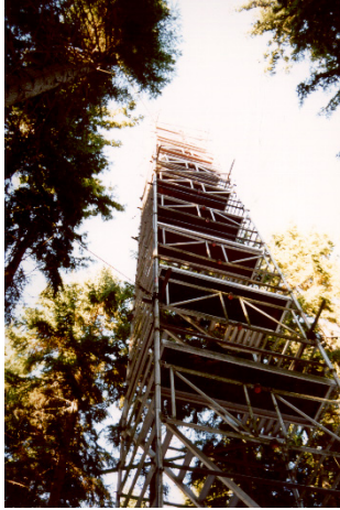
Rotherdbach: Messturm für Klimamessungen 1996-2009
