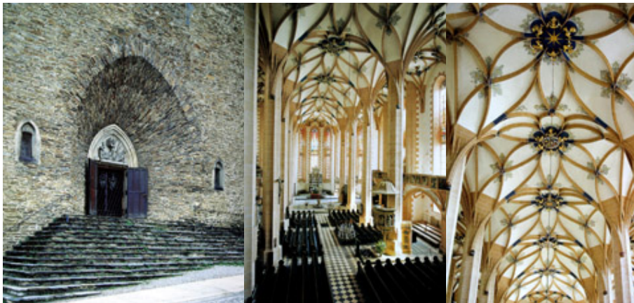
Westportal aus Bruchstein
