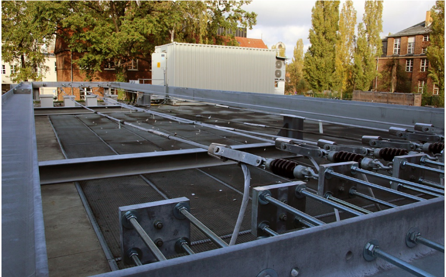
Bild 1: Freiluftversuchstand zum Untersuchen von stromführenden Verbindungen für Leiterseile bei kombinierter elektrisch-thermischer und mechanischer Belastung
