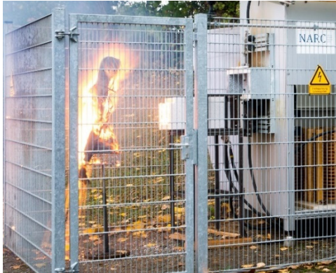
Test-Dummy nach Störlichtbogenereignis Foto: Karsten Wenzlaff
