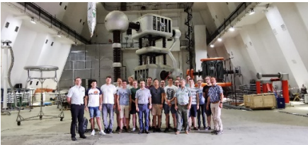
Hochspannungshalle im EGU Bechovice
