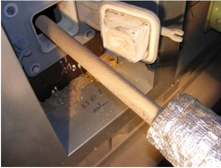
a) Herausziehen einer Sonde mit Belag
