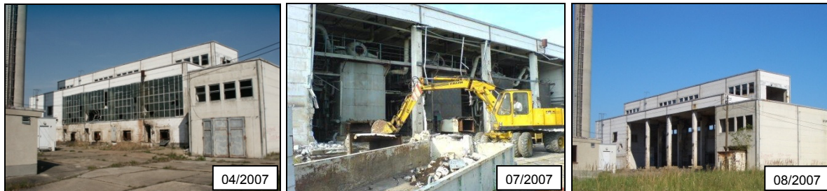
Abbildung 5: Arbeiten zum Rückbau der Dampfkesselanlagen im alten Heizhaus Lautex
