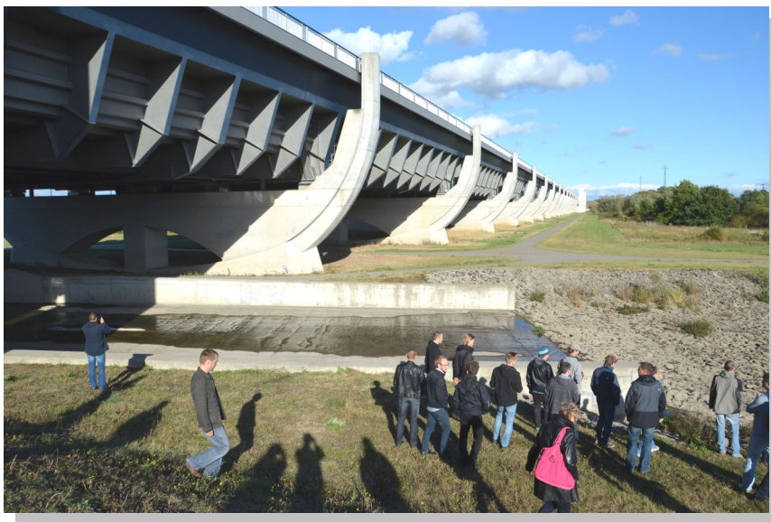
Der Mittellandkanal in der Trogbrücke über die Elbe
