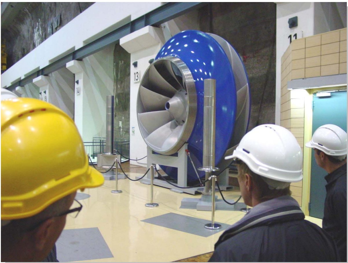
Im Kavernenkraftwerk des PSW Goldisthal
