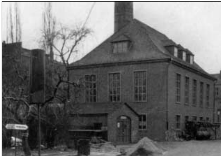
Ansicht der Übergabestation aus dem Jahre 1958
