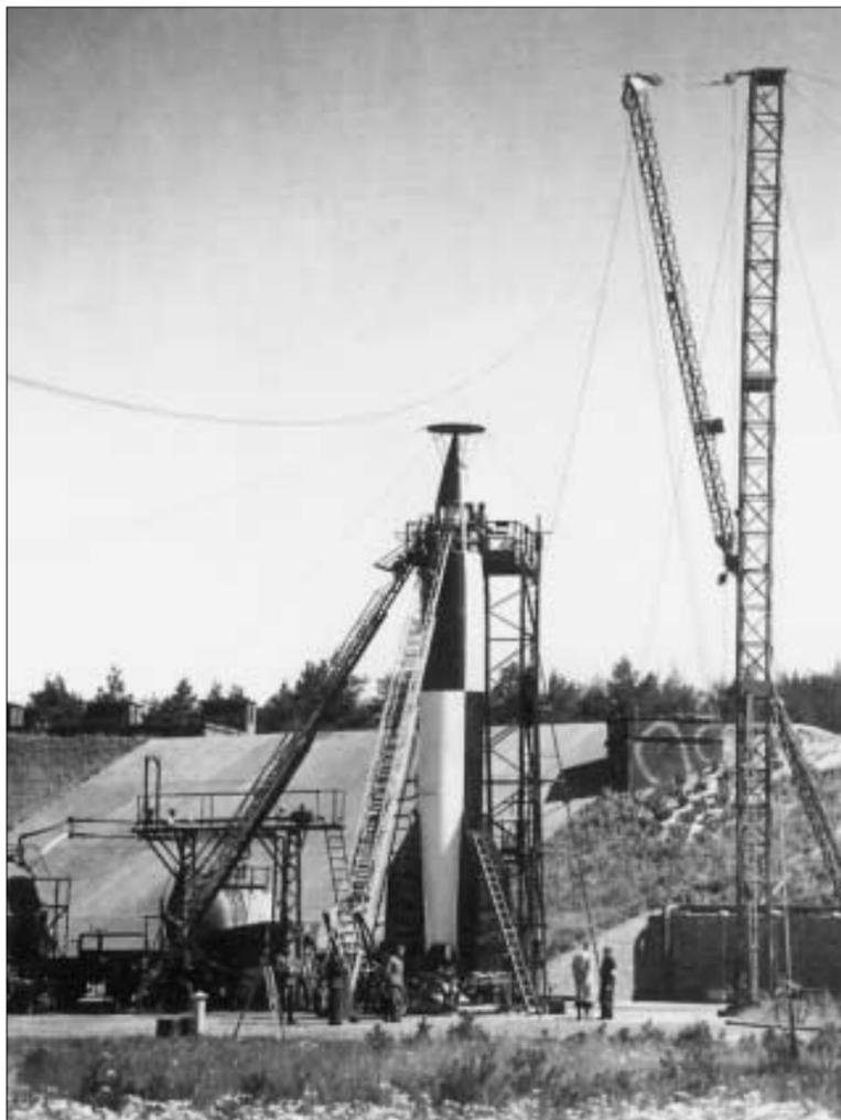
Vorbereitungen zum Versuchsstart einer „Aggregat 4“-Rakete auf dem Prüfstand 7 in Peenemünde. Fotos (3): Archiv des Autors
