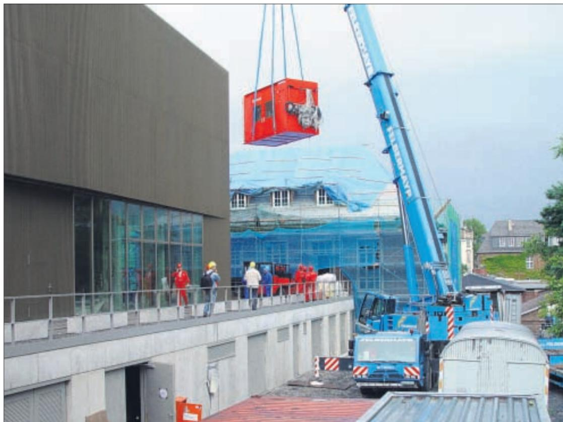
Ein lang ersehnte Lieferung erreichte am 18. August den Neubau des Zentrums für Energietechnik der TUD: die neue 600-KW-Gasturbine. Das 12,5 t schwere Aggregat von Kawasaki wurde pünktlich ab 8 Uhr vom Tieflader in seinen künftigen Standort gehoben. Die Turbine ist Kern eines innovativen Kraftwerksprozesses, der im Zentrum demonstriert und untersucht werden soll. Es handelt
