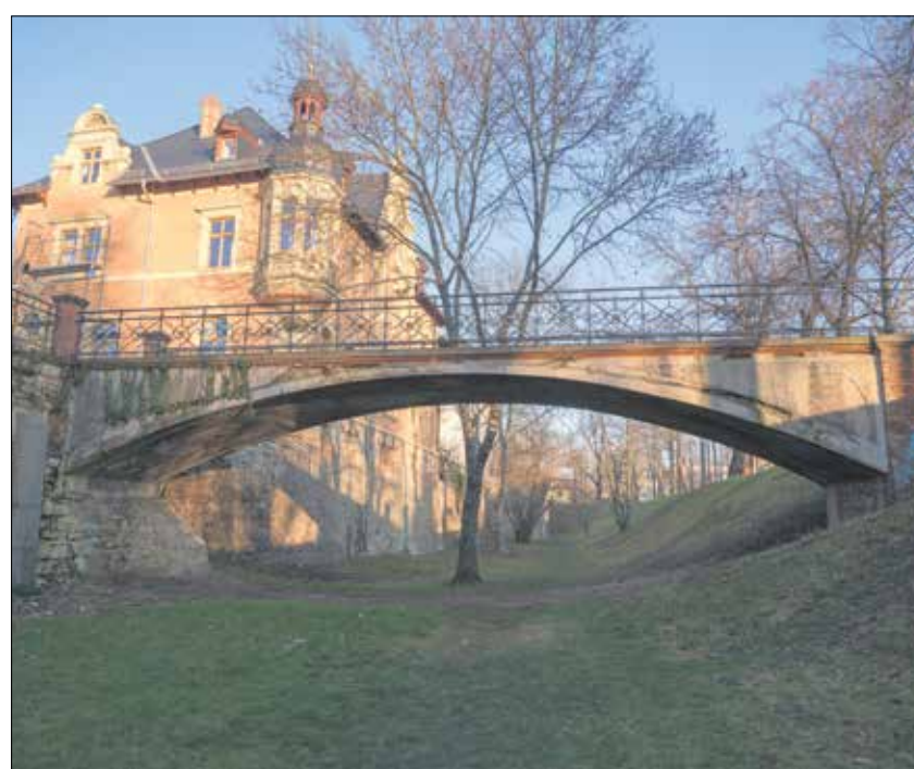
Soll mit Carbonbeton vor dem Abriss bewahrt werden: denkmalgeschützte Brücke in Monierbauweise an der Thainburg in Naumburg. Foto: Dr. Harald Michler
