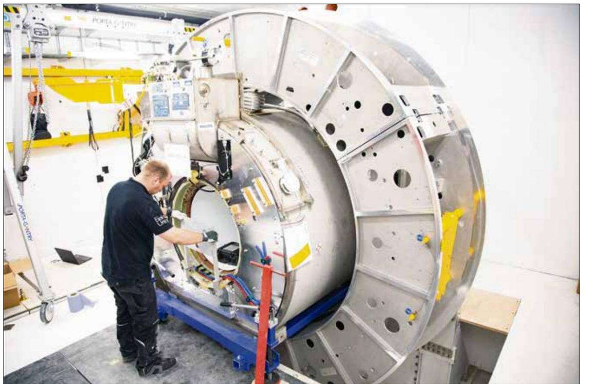
Der MR-Linearbeschleuniger zur individualisierten hochpräzisen Bestrahlung wird im NCT/UCC installiert.
