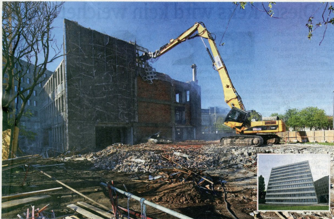
Etage für Etage ist das blaue Haus seit Oktober geschrumpft. Gestern hat ein Bagger die restlichen Abrissarbeiten an der früheren Pädagogischen Hochschule übernommen.
